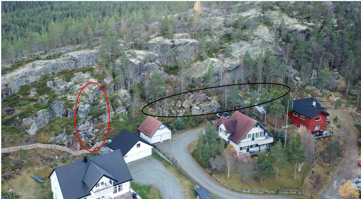
Figur 8: Dronebilde fra område øst. Rød ring viser avløste blokker dimensjonerende for faresonen med årlig sannsynlighet 1/100. Svart ring viser området med store blokker, som sannsynligvis stopper evt. nye utfall.
