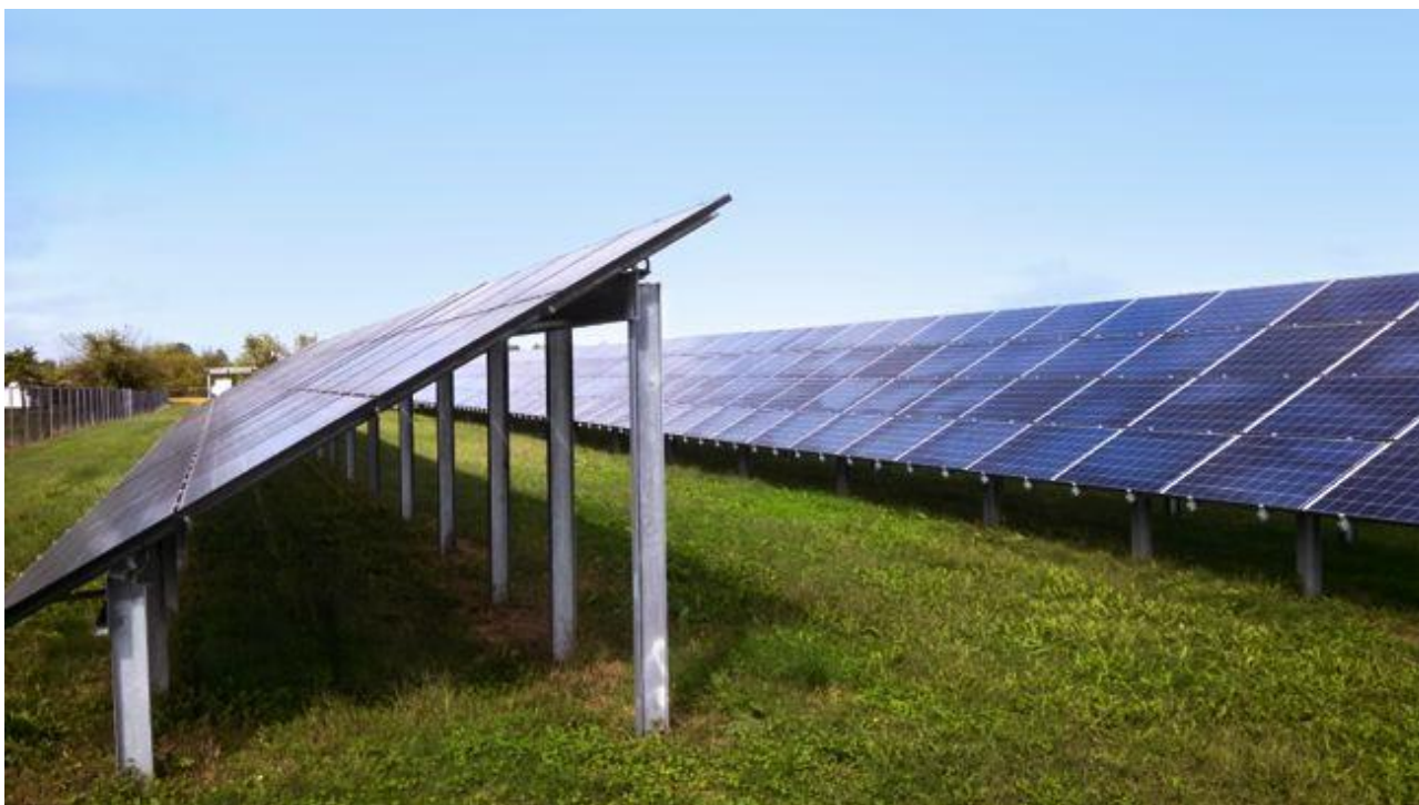
Figur 3-1: Fast-vinkel installasjonsløsning (foto: Willowbrook Solar).
