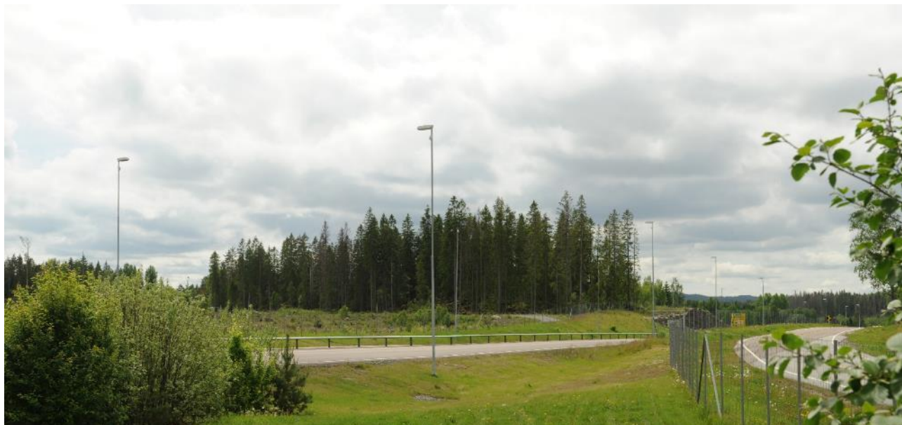
Figur 5-19: Førbilde av planområdet for solkraftverket, sett fra rasteplassen som ligger på motsatt side av E18.
