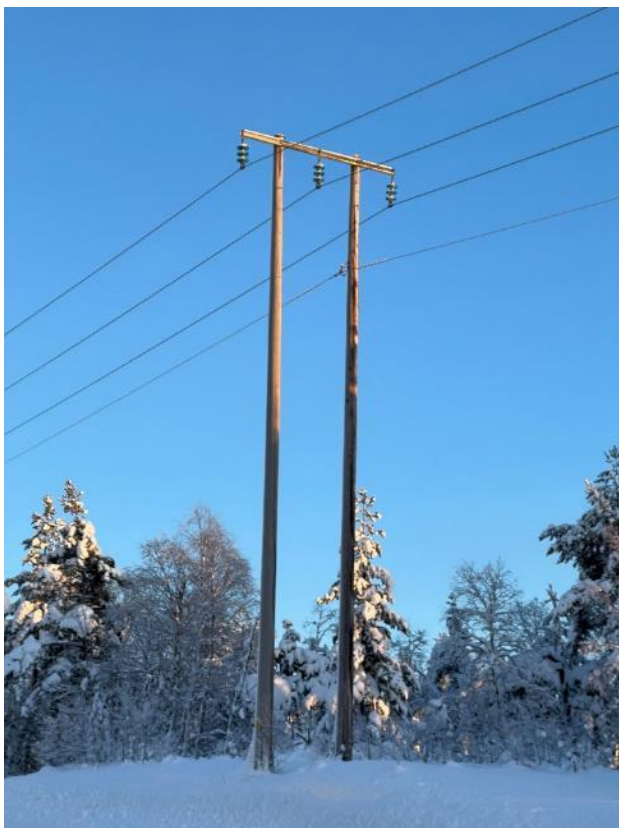
Figur 5-23: 22 kV Kraftledningsmast med tilsvarende dimensjoner som planlagt
