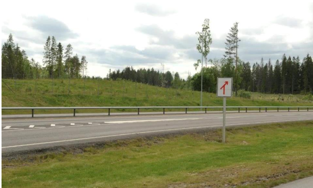
Figur 5-24: Støyvoll anlagt langs E18 mellom veien og tiltaksområdet for solkraftverket. Det planlagte tiltaksområdet er synlig til høyre i bildet, der vollen slutter
