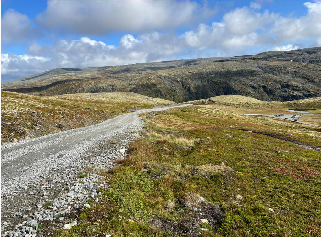
Bilde 8: Veg R3 på Aurlandsfjell som er opprustet og hvor det er lagt nye stikkrenner. Her er det god tilpasning til eksisterende landskap. Foto: NVE.
