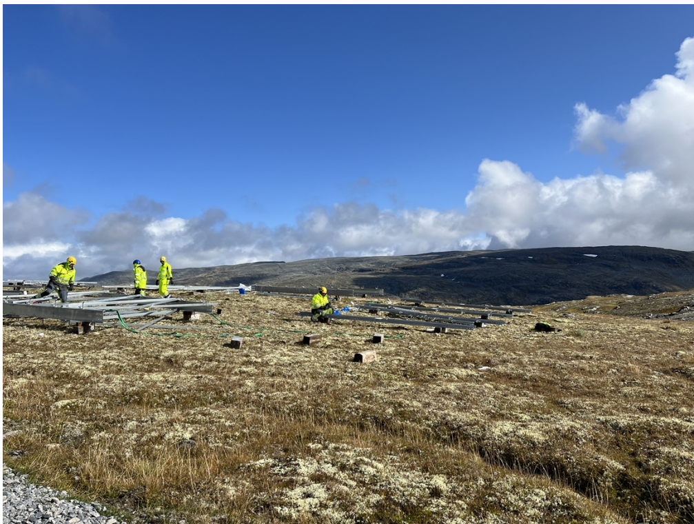
Bilde 3: Arealbruk langs veg nr R3 på Aurlandsfjell, som brukes til premontering av master. NVE mener det er svært positivt at Statnett og entreprenør finner løsninger som minsker inngrep. Foto: NVE.
