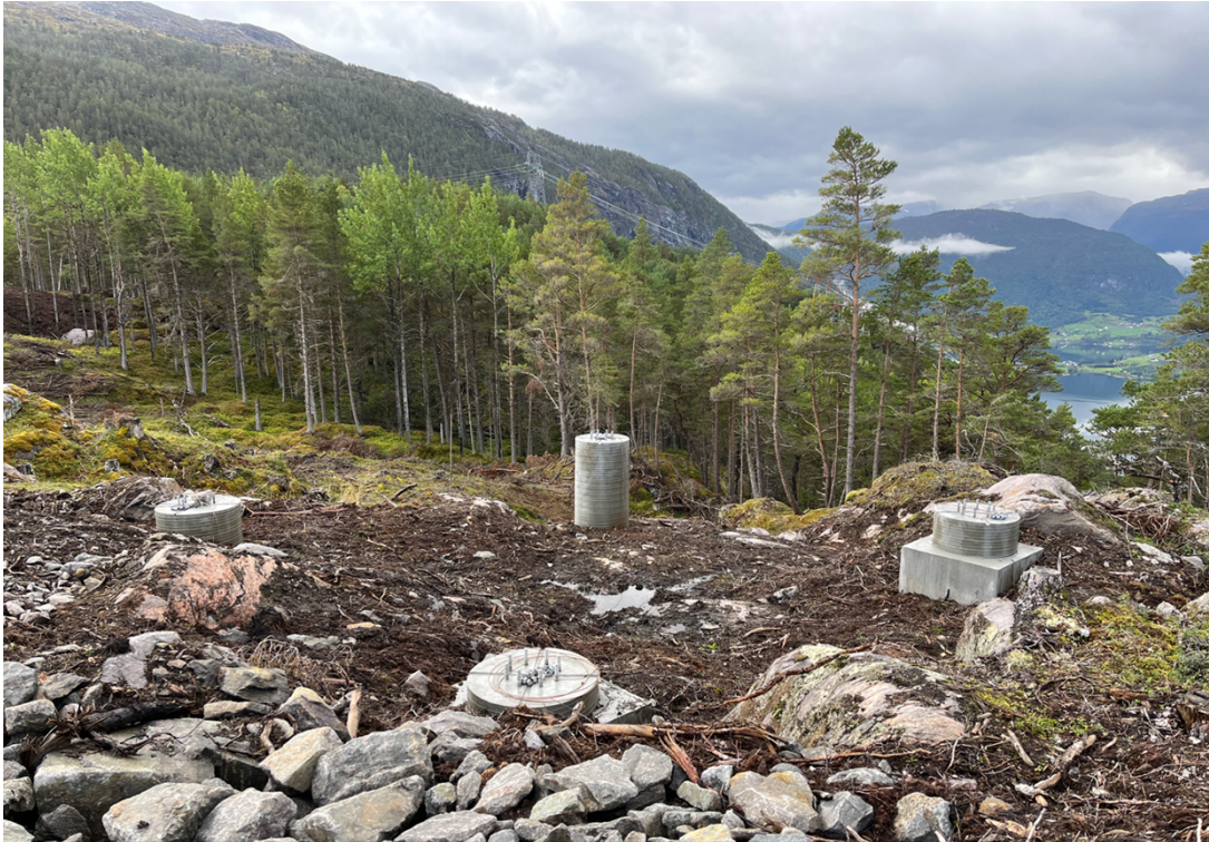
Bilde 13: Fundamenter til fjordspennmaster i skogsterreng ved B27 på Vinestølen. Her er mer av terrenget berørt, men istandsettingen er god, og tilveksten i området antas å være forholdsvis rask. Eksisterende ledning skimtes bak trærne midt i bildet. Foto: NVE.
