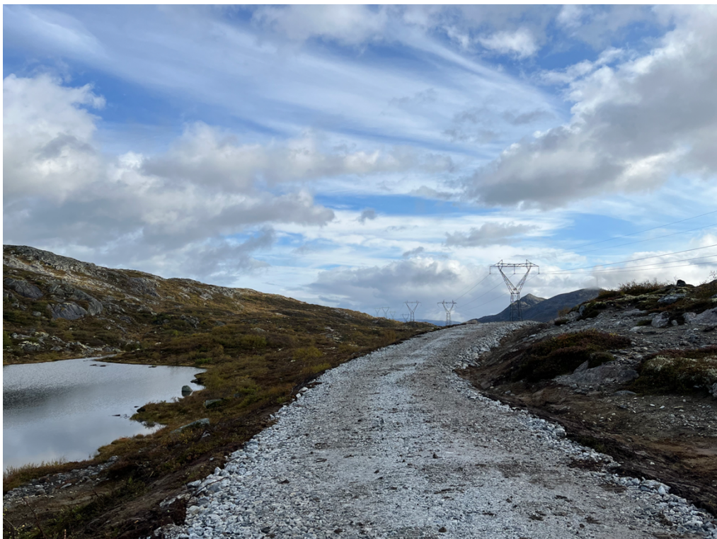
Bilde 6: Eksempel på ny veg R8 på Fimreite som er bygget av Statnett. Vegen ligger fint i terrenget, og vekstmasser er lagt tilbake på siden av veien slik at vegen blir godt avgrenset mot tilgrensende landskap. Foto: NVE.
