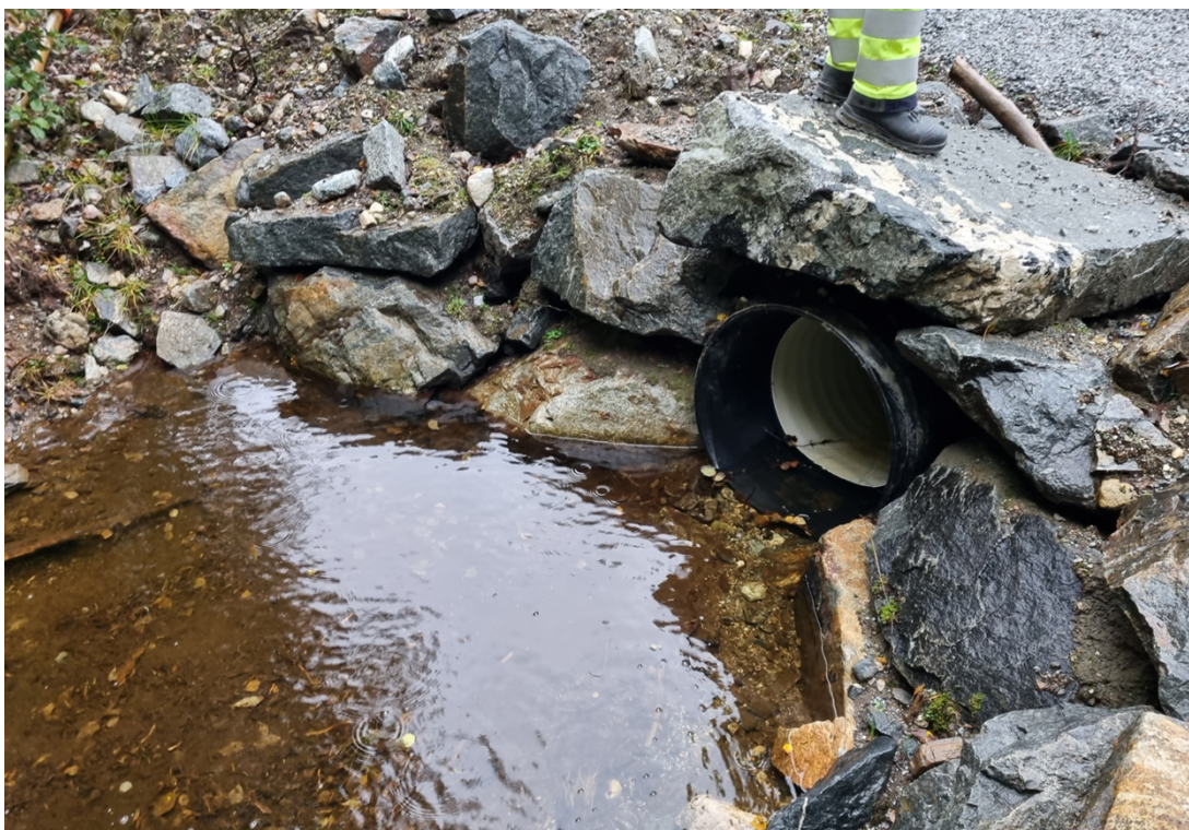
Bilde 7: En stikkrenne langs veg R10 på Fimreite hvor større stein er brukt til forbygning rundt selve rennen. Foto: NVE.
