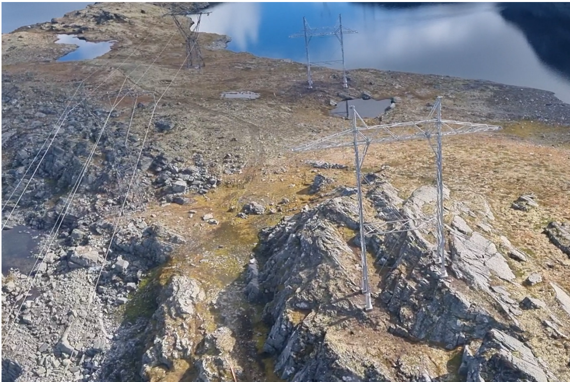
Bilde 12: Mastefundamentering og mast 48/49 på Aurlandsfjell til høyre i bildet. Det er lite spor etter arbeidet i fjellterrenget. Eksisterende ledning til venstre. Foto: NVE.
