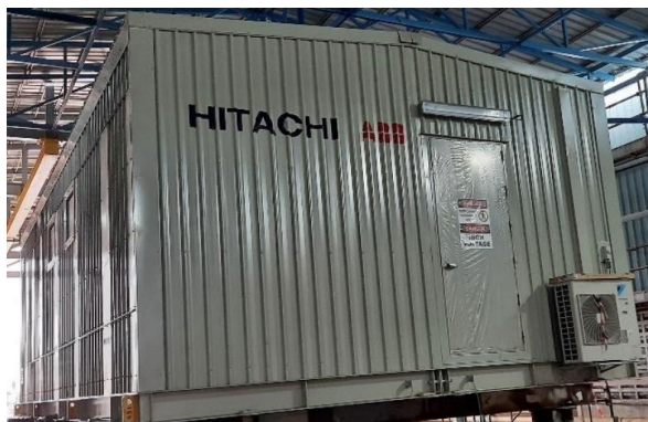
Figur 12 Planlagt container for 24 kV bryteranlegg, det blir plassert 3 slike på hver transformatorstasjon
