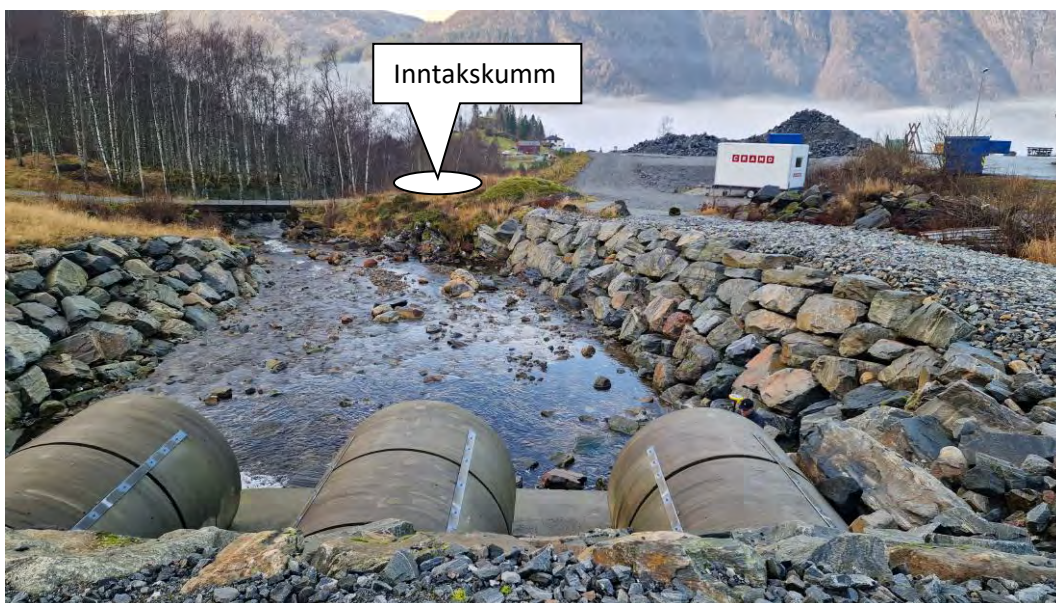
Bilde område for planlagt rørgatetrase øvre del
