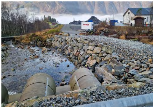
Bilde nedstrøms planlagt inntaksområde
