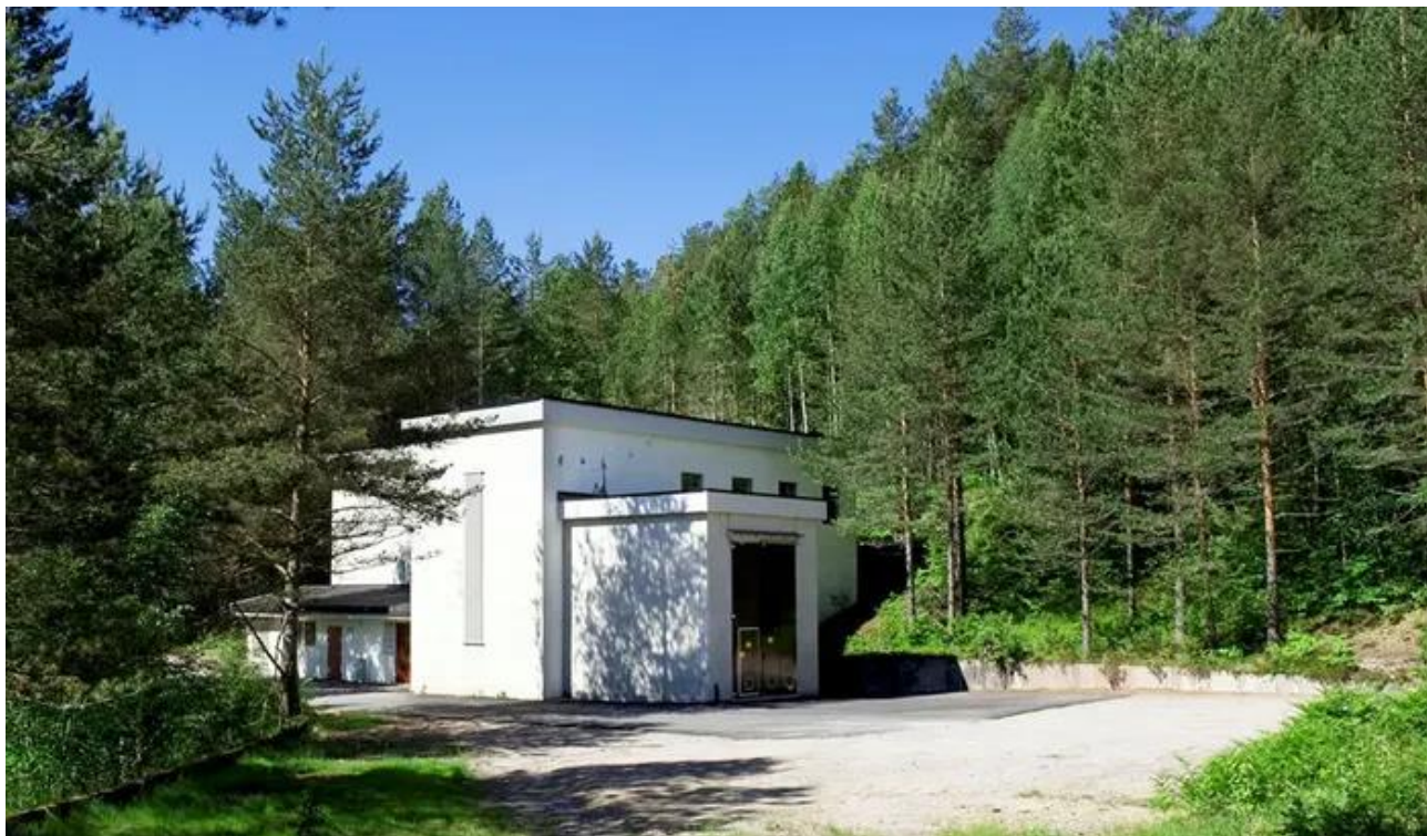
Figur 2-4: Berlifoss kraftverk Foto Å Energi
