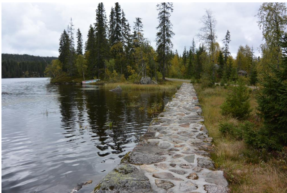
Figur 2-1 Dam Tverrsjøen ble rehabilitert i 2011. Dam Skarvvatnet er tenkt rehabilitert på samme måte. Foto: Multiconsult Norge AS.
