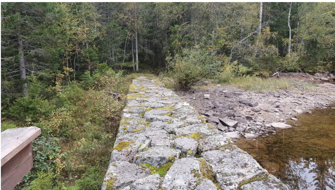
Figur 1-3 Skarvvatnet dam, vestside. Foto: Multiconsult Norge AS.
