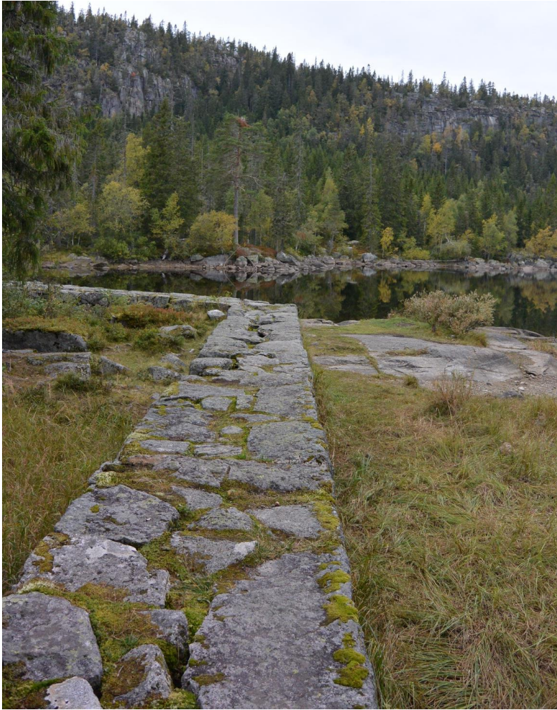
Figur 1-2 Skarvvatnet dam, østside. Foto: Multiconsult Norge AS.
