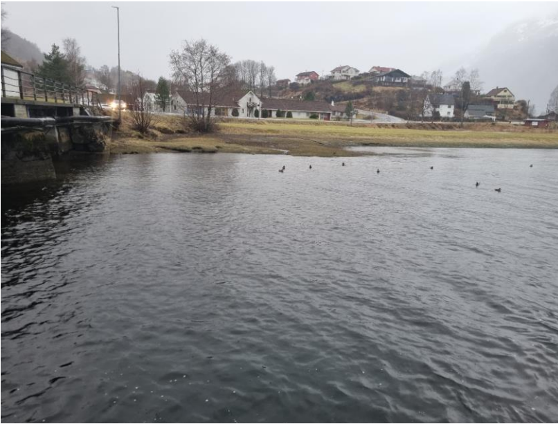
Figur 2-2 Erosjon Dalselva ved utløp til Dalsfjorden
