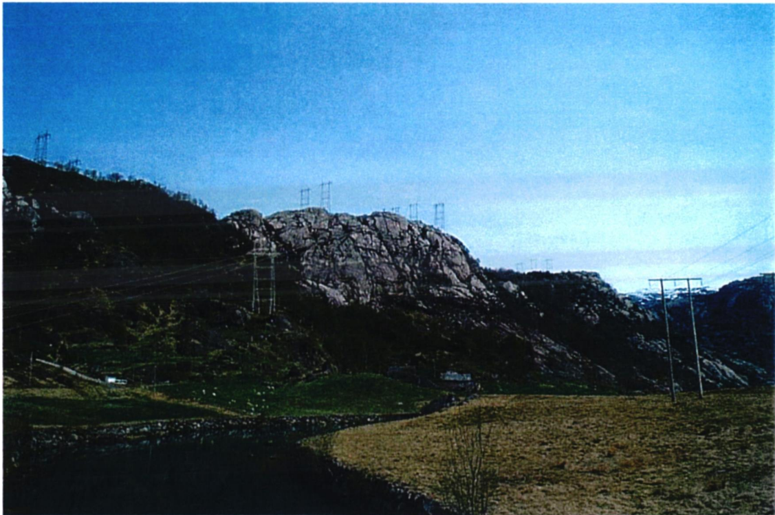
Figur 8 Kraftledning etter Alternativ 1 sett fra Vik.
