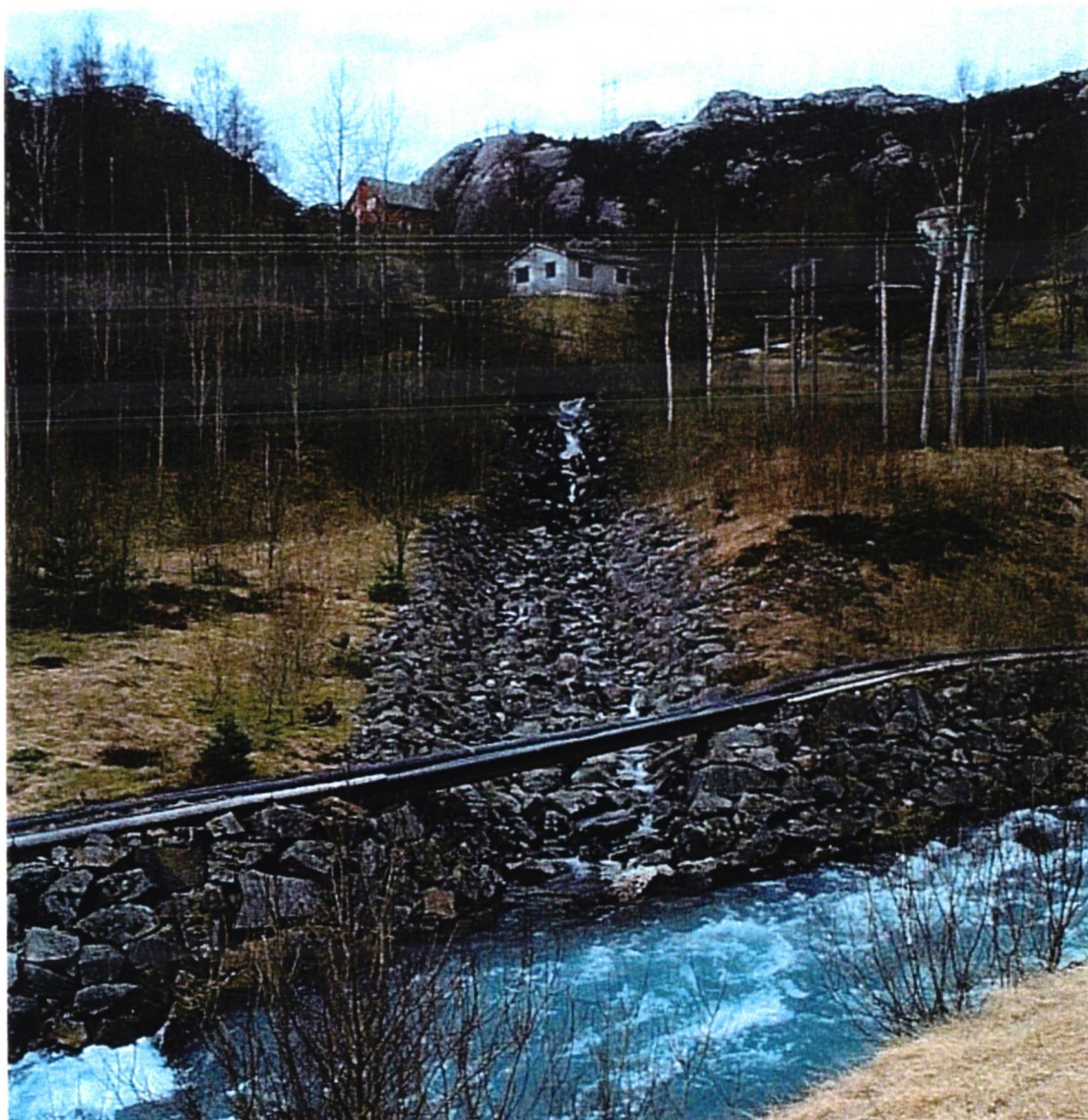
Figur 3 Kvernabekken 7.4.2001 der den kommer inn i kraftverkskanalen fra Blåfalli II (Foto: Finn Gravem).
