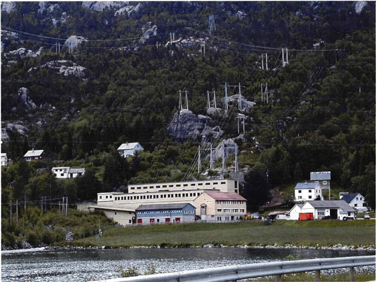
Bilete av eksisterande Blåfalli II kraftstasjon (juni 2000)
