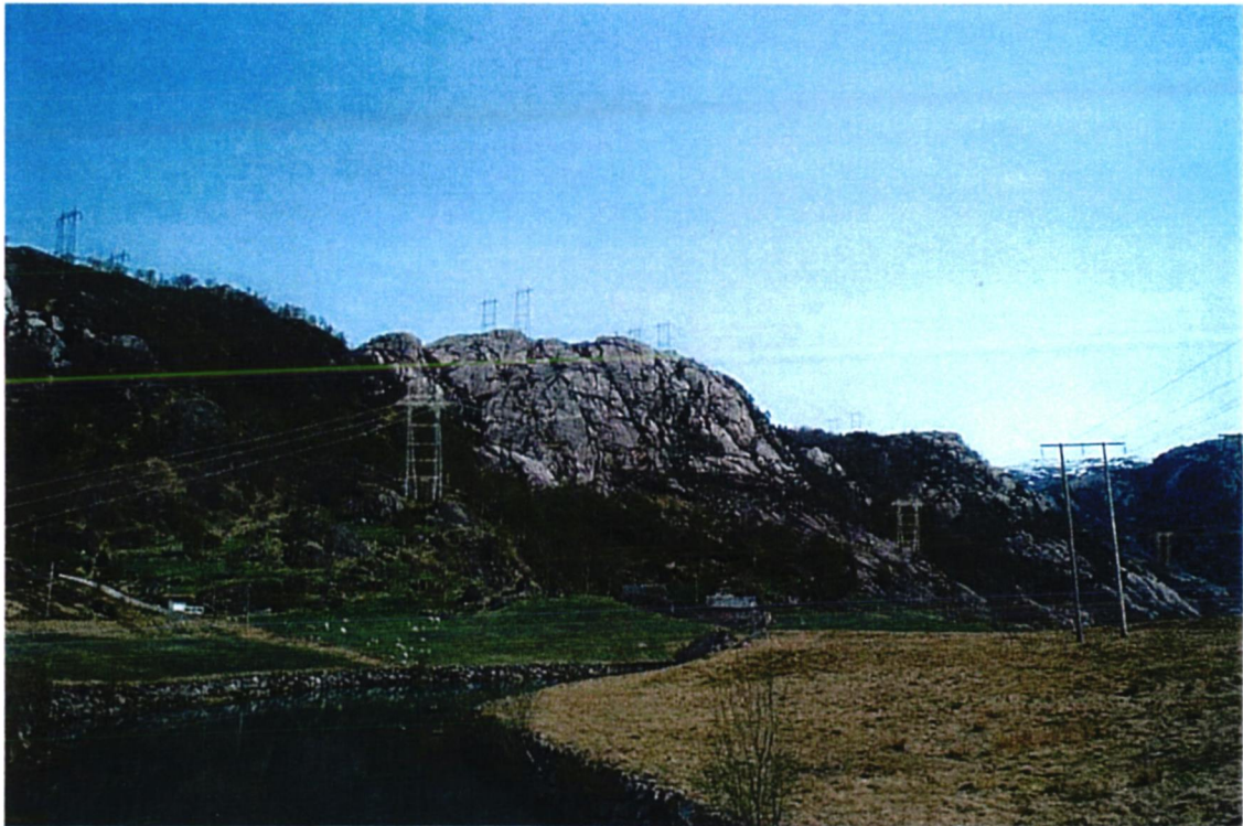
Figur 9 Kraftledning etter Alternativ 2 sett fra Vik.
