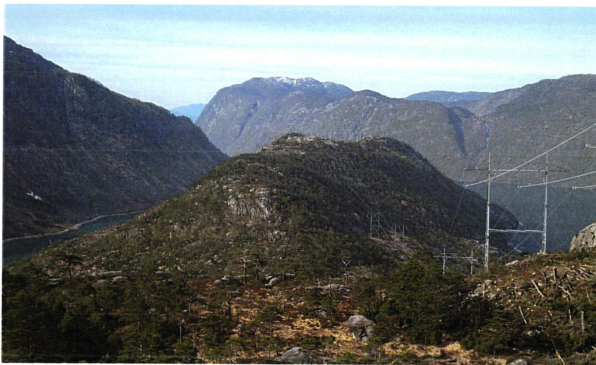
Figur 9.3.-1 Dagens situasjon med kraftlinjer. Åsen sett fra Rispa (Fylkesvei 40).
