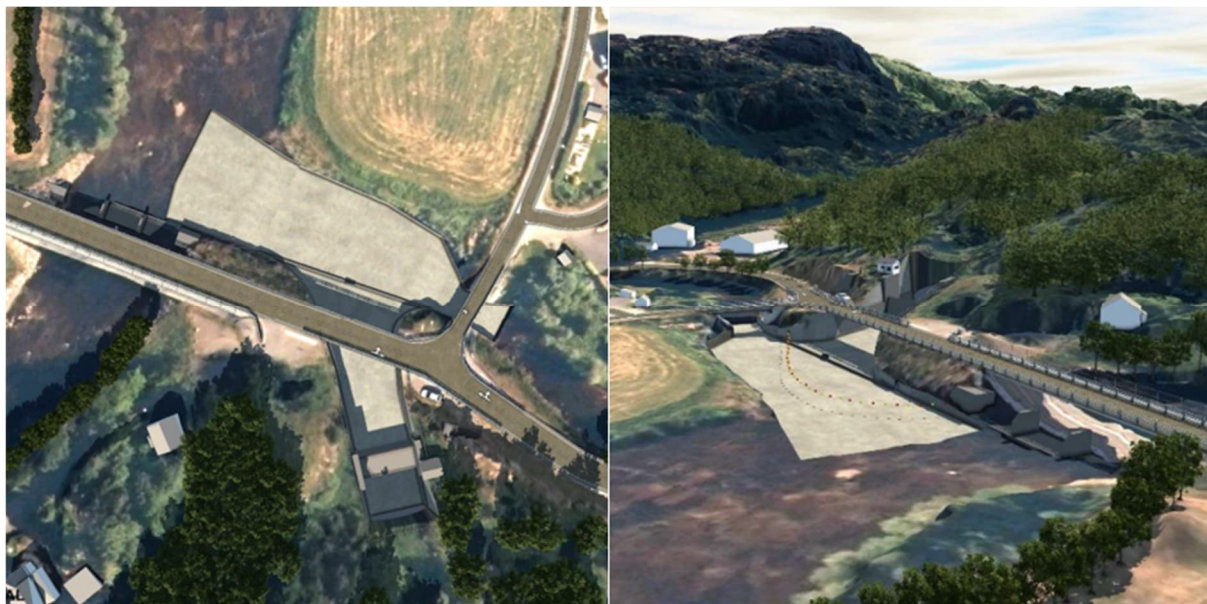
Figur 3-4: Visualisering av inntak og luker i elva uten vann. De gråmarkerte flatene skal dekkles med grov stein for å skape gode leveområder for ungfisk.
