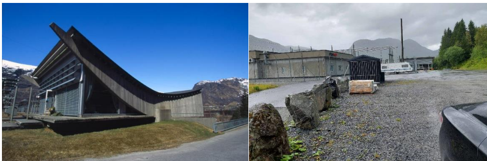
Portalbygget Røldal kraftverk Arkitekt Geir Grung
