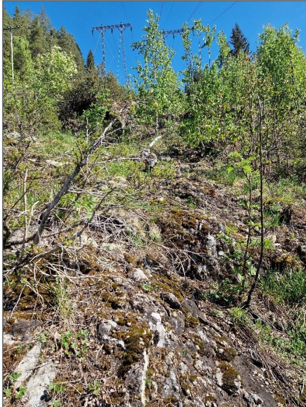
Figur 20: Til venstre: Skrint løsmasse og mye bart berg langs eksisterende linjetrasé. Til høyre: Tegn til sesongbasert vannføring i søkk nord for kartleggingsområdet (vest for kraftlinje).
