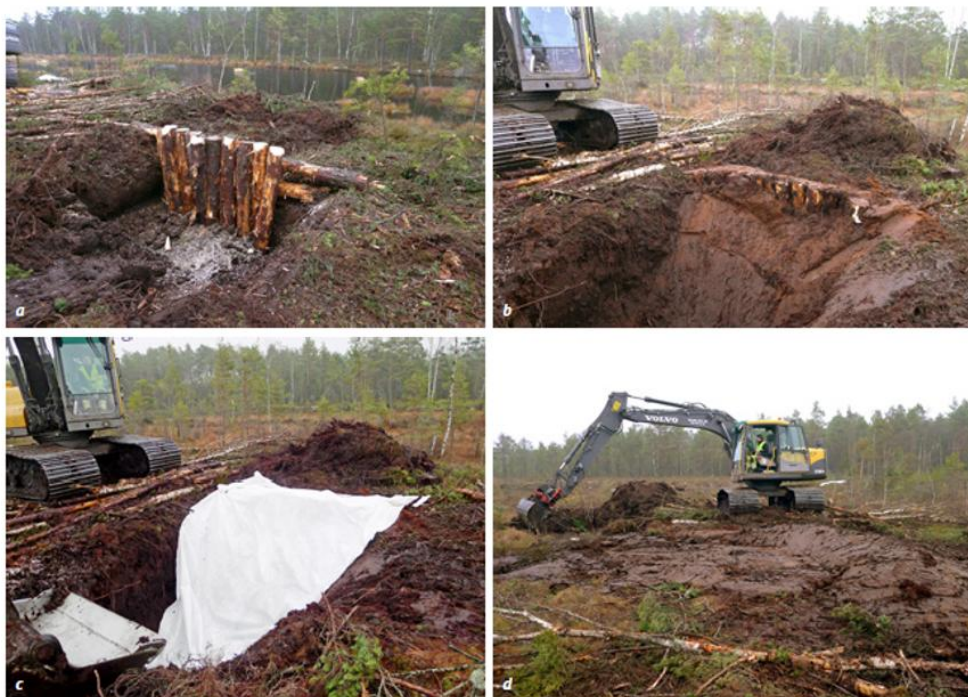
Figur 17. Viser metodikken for å bygge en demning med en kjerne av stående stokker.
