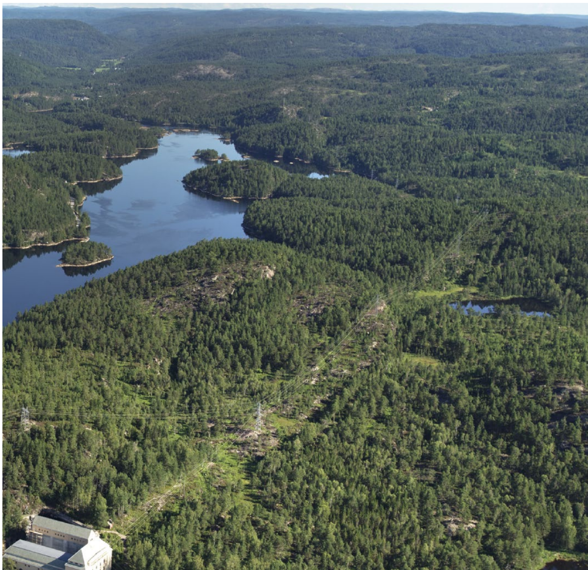
FIGUR 4 - Å ENERGI VANNKRAFT AS SIN 11 kV LINJE SETT FRA NOMELAND KRAFTSTASJON MOT IVELAND KRAFTSTASJON.
