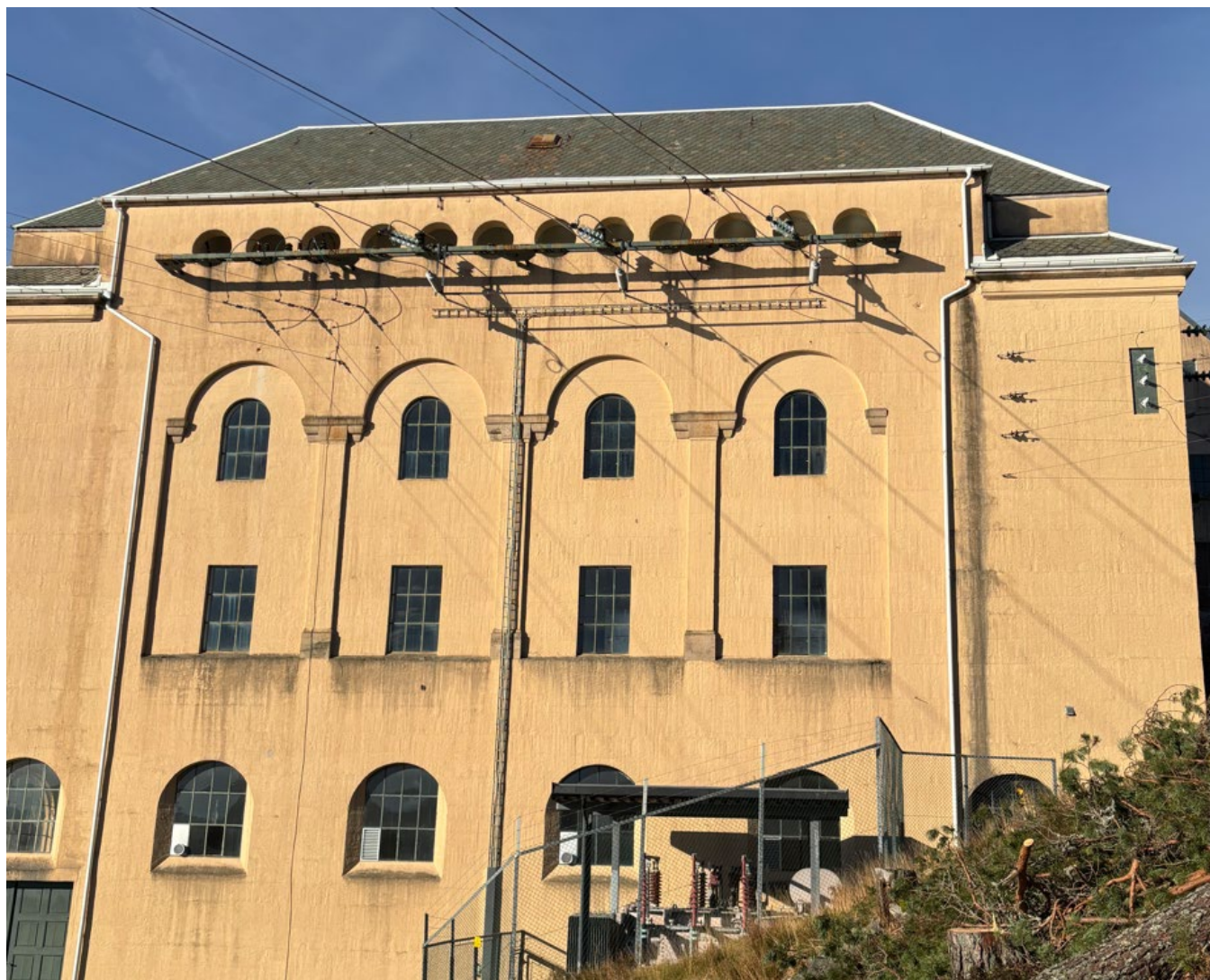
BILDE 1 VEGG PÅ NOMELAND KRAFTSTASJON HVOR 11 kV LINJE KAN SES TIL HØYRE I BILDET
