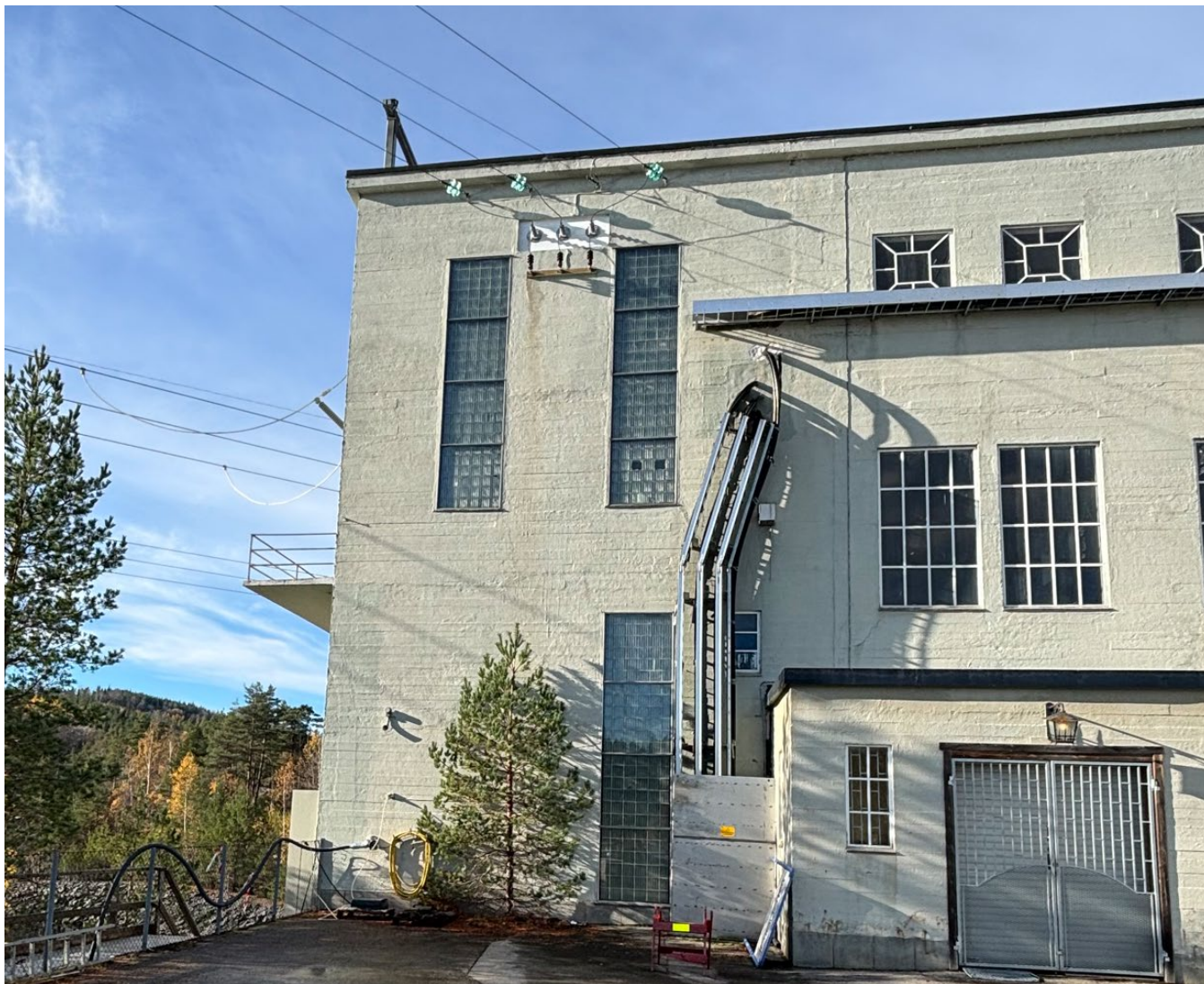
BILDE 2 IVELAND KRAFTSTASJON. 11 kV LINJE SES I TOPPEN AV BILDET
