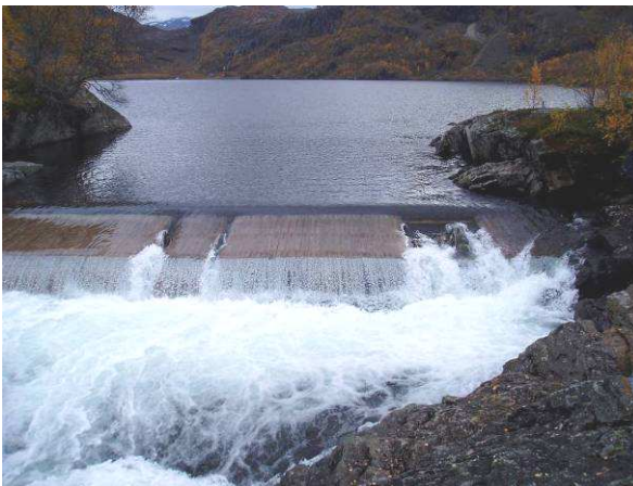
Dam sett østover (før rehabilitering)
