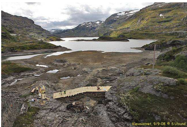
Rehabilitering av Klevedammen, nedtappet magasin
