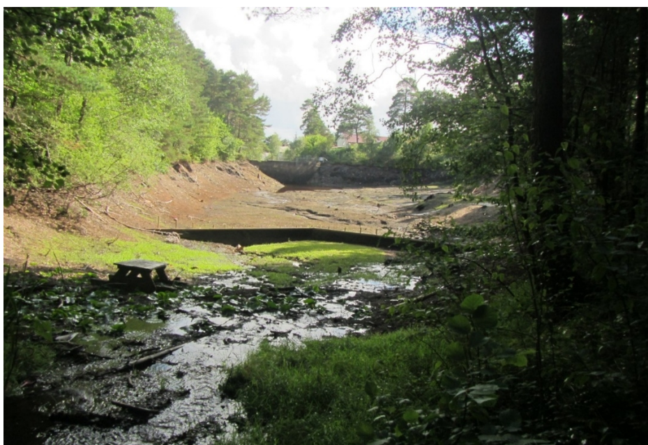
Figur 2 Bildet er tatt i nordenden av dammen. Dammen ble tappet ned i 2022. Det er etablert et midlertidig tiltak med en provisorisk "demning" som skal bevare fuktigheten til forekomsten av den sterkt truede arten soleigro (EN). Foto: Arne Vatten
