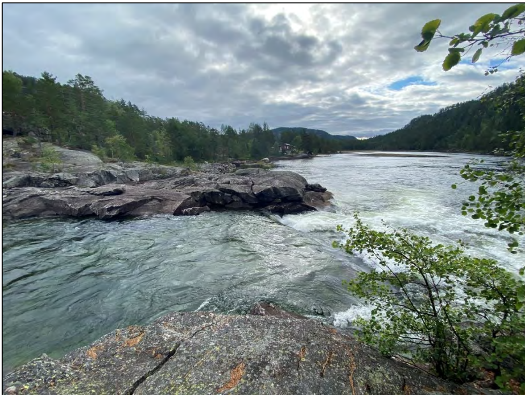
Figur 2-5. Utløpet av elva i Glomsura nedstrøms elvestrekningen. Høydeforskjell fra dam er i dag 1-2 m, men vil bli betydelig redusert ved at elvebunnen senkes. Deler av bergnabben midt i bildet må sprenges bort for etablering av kanal. Bildet er tatt mot sør. Foto: Sweco Norge.
