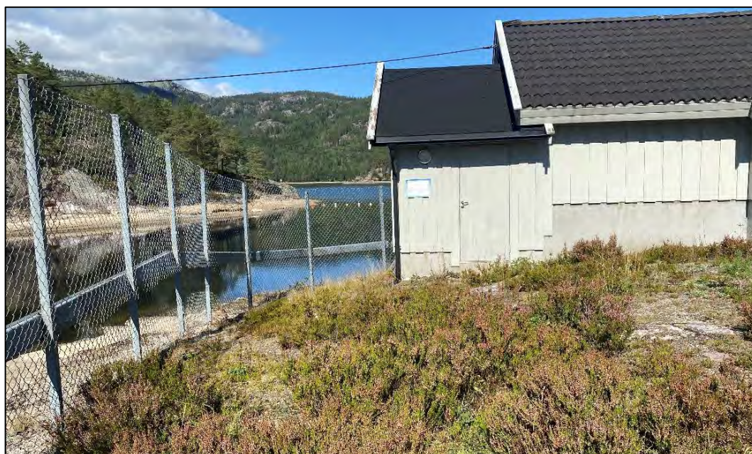
Figur 2-6. Dagens inntak ved lukehuset. Foto: Sweco Norge.
