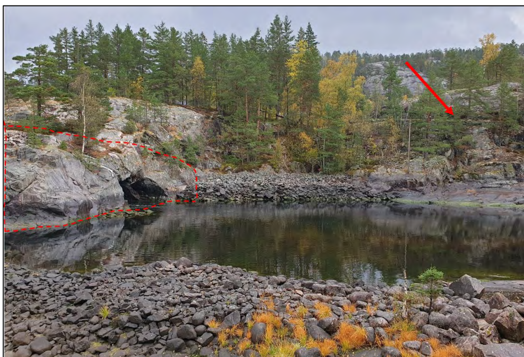
Figur 2-10. Glomshylen med dagens tunnel i bakgrunnen med vannføring 8,9 m 3 . Ny anleggsvei vil gå ned i magasinet til venstre i bildet og kraftstasjon legges ved dagens utløpstunnell i bakgrunnen. Anslått utsprengt areal er angitt med rød stipling. Rød pil angir Postveien. Foto: Sweco Norge.
