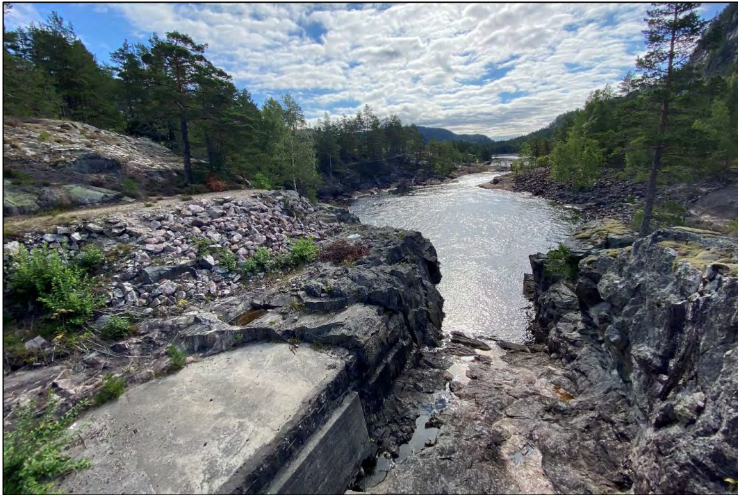
Figur 2-4. Dagens utløpskanal fra tappeluker i dam. Foto: Sweco Norge.
