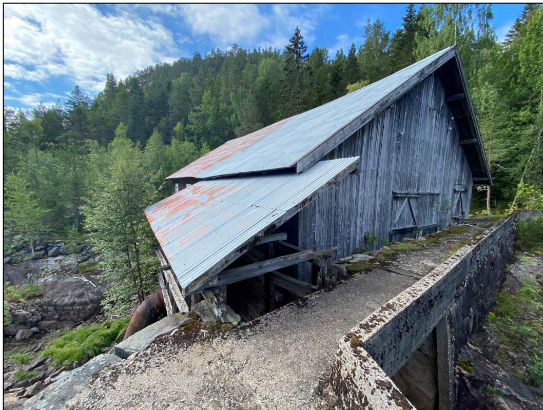
Figur 5-4. Sagbruket sett fra nord. Foto: Sweco Norge.
