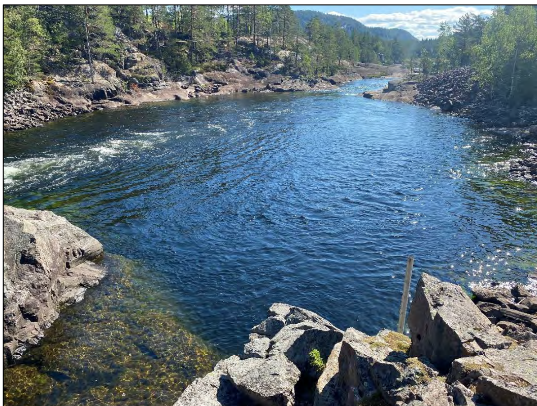
Figur 2-3. Kulp nedstrøms dam der ny avløpstunnel skal plasseres til venstre i bildet. Glomshylen og elva nedstrøms vises i bakgrunnen, bildet er tatt mot sør. Foto: Sweco Norge.
