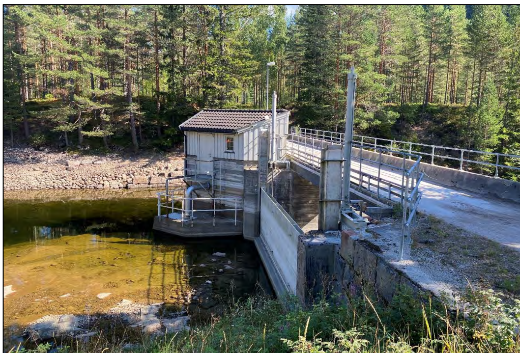
Figur 2-1. Utløp ved Russdam. Her er minstevannføringen 0,5 m 3 /s. Det skal ikke gjøres noe med denne dammen i forbindelse med tiltaket. Foto: Sweco Norge.
