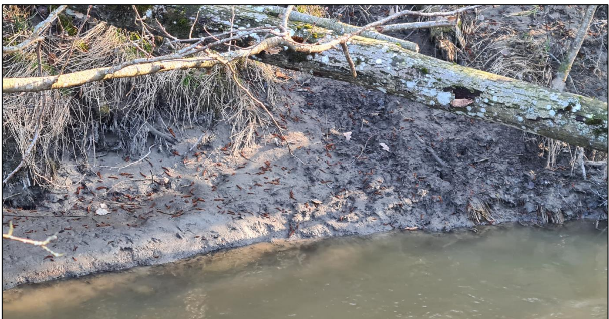
Figur 4.15: Ofte sett under befaring: Avsetninger av siltige, sandige masser langs bekkesidene (Fra befaring 09.04.2021)
