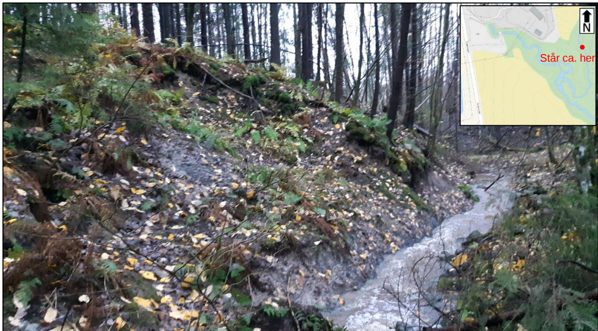
Figur 4.17: Står i ravedalen og tar bilde mot nord, som viser en overflateglidning som er gått i skråningen med synlige leire i bunn skråning. Bildet ble tatt på høsten etter en periode med nedbør (Fra befaring 02.11.2020)
