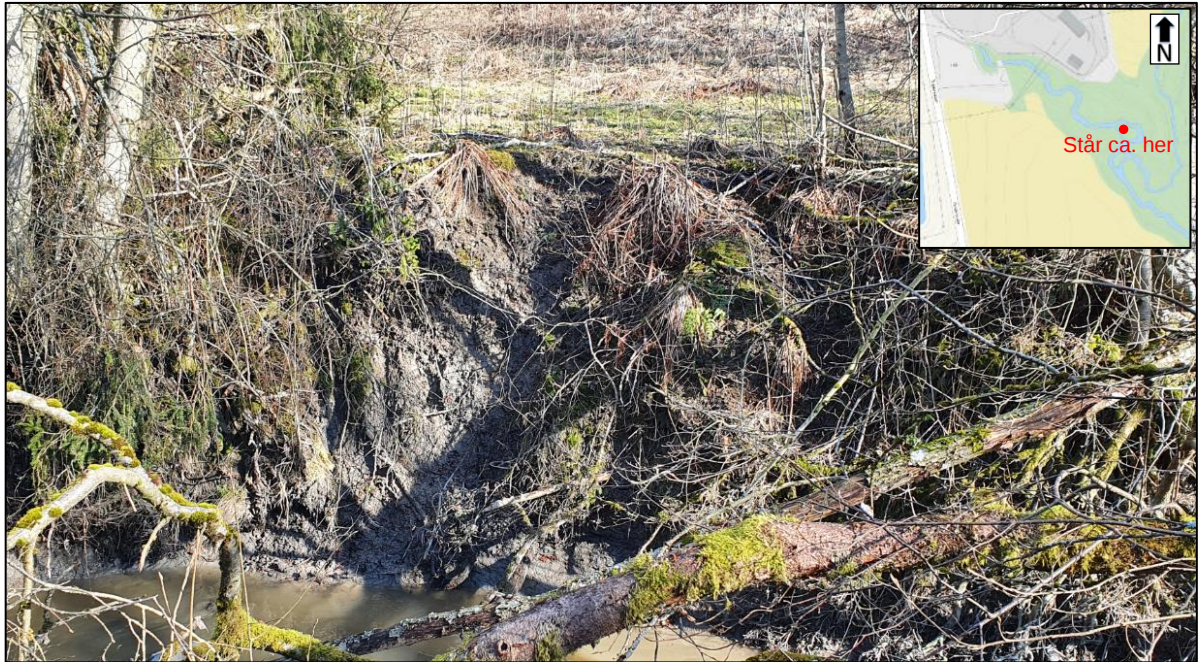
Figur 4.16: Står i ravedalen og tar bilde mot jordet i nord, som viser kanalisering (utgraving) som følge av erosjon fra overvann over tid (Fra befaring 09.04.2021)
