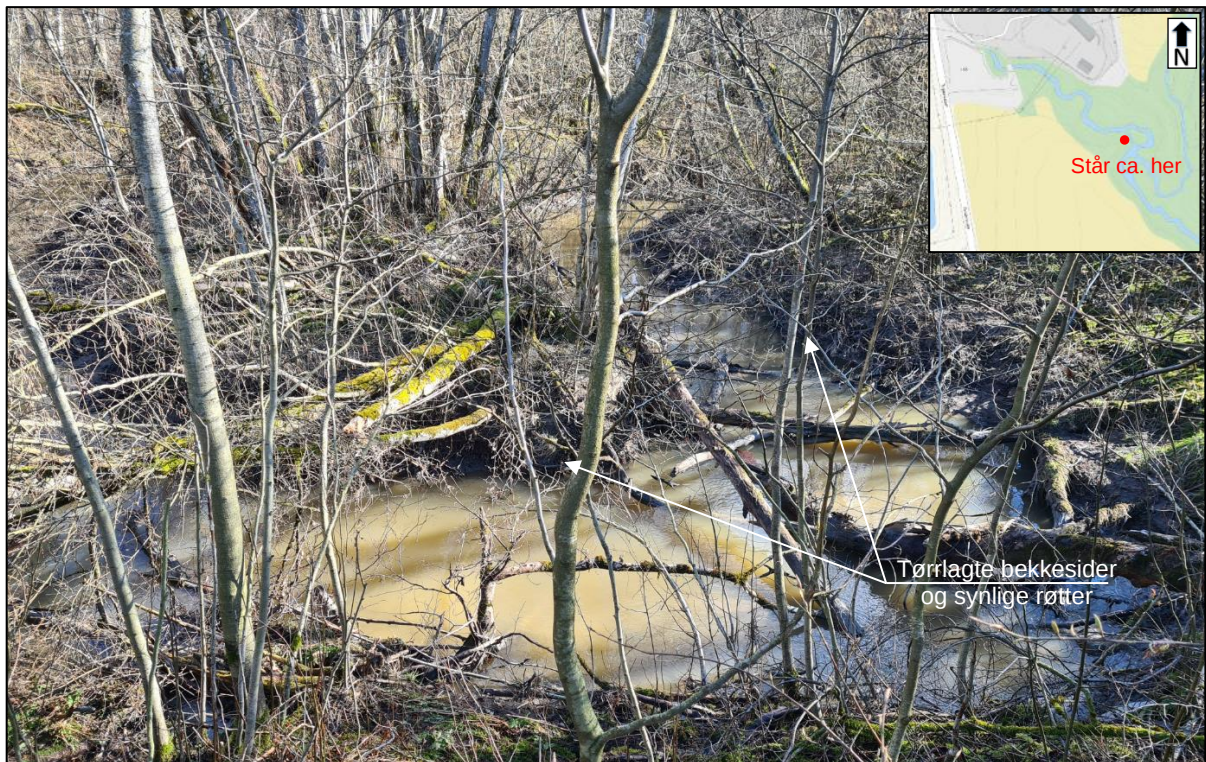
Figur 4.14: Står i ravinedalen og tar bilde mot nord, som viser synlige røtter og avsetninger av silt og sand som indikerer utvasking og pågående erosjon av bekkesidene. (Fra befaring 09.04.2021)
