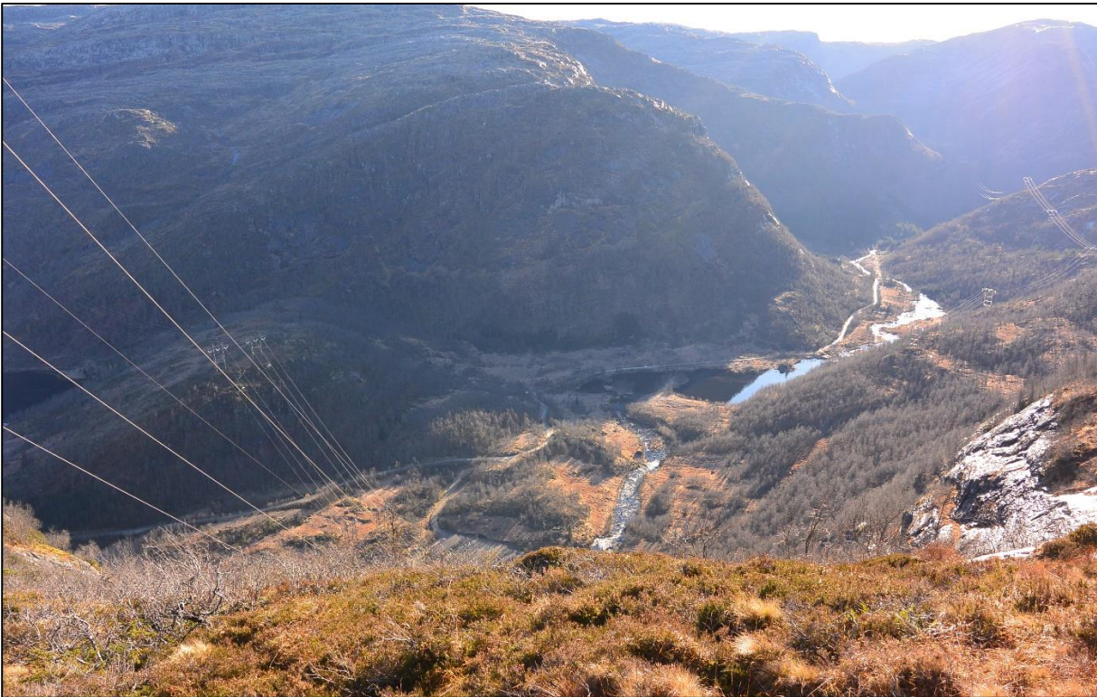
Figur 29. Viser området rundt eksisterende transformatorstasjon sett fra høydedraget ved Støfjellet/Nåmdalsfjellet. Eksisterende kraftledningstrase inn mot transformatorstasjonen kan sees til venstre i bildet. Eksisterende transformatorstasjonstomt kan delvis sees ved enden av veien/utposningen av veien omtrent midt i bildet. Herfra ser man godt både den parallelle traseen som går sørøstover ut fra transformatorstasjonen og traseen som går sør/sørvestover nedover mot Krossdalen i tillegg til kraftledningen tettest på til venstre i bildet.
