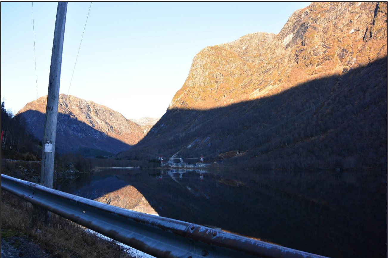
Figur 21. Bildet viser eksisterende Steinsland koblingsstasjon sett fra Fv 5412 i sørvest, langs Steinslandsvatnet.
