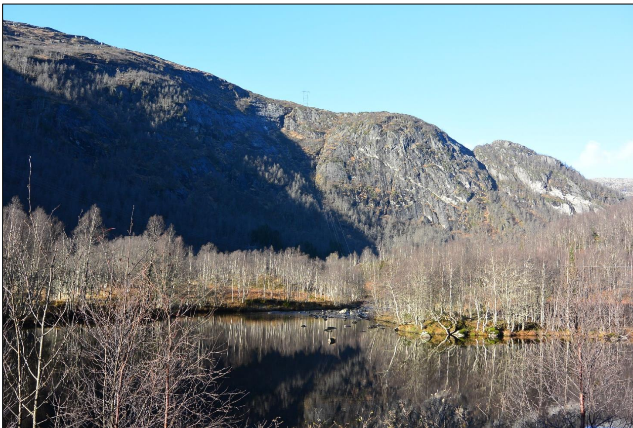
Figur 31. Foto tatt fra Krossdalen mot nord og Krossdalen transformatorstasjon. Eksisterende mast er synlig mot horisonten.
