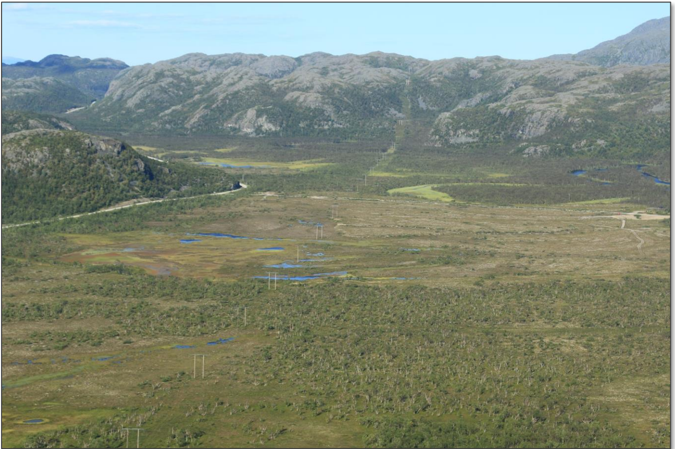
Ved Statnetts omsøkte transformatorstasjon i Adamsfjorddalen
