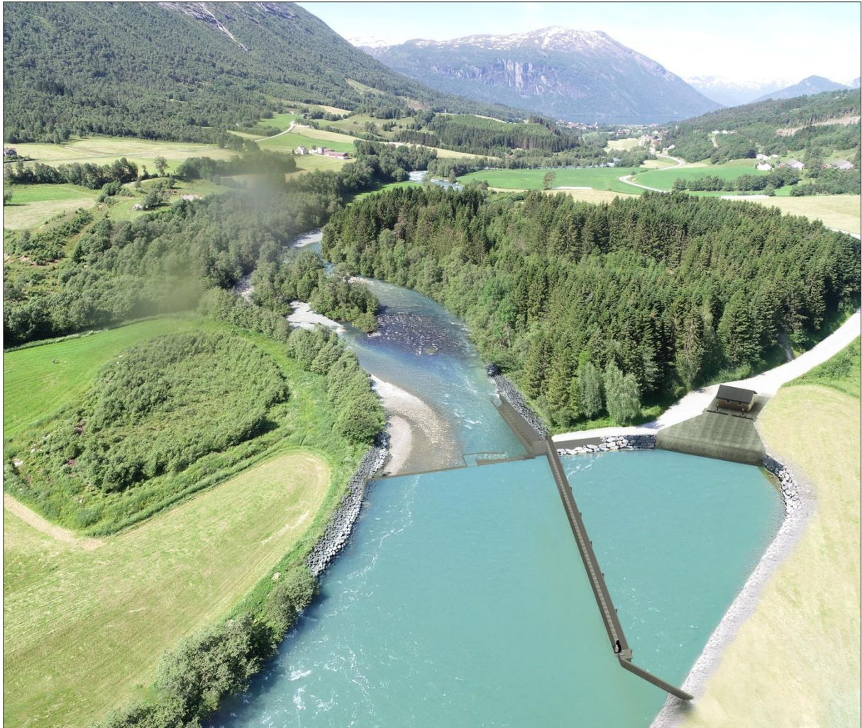
Dam/inntak i Storelva
