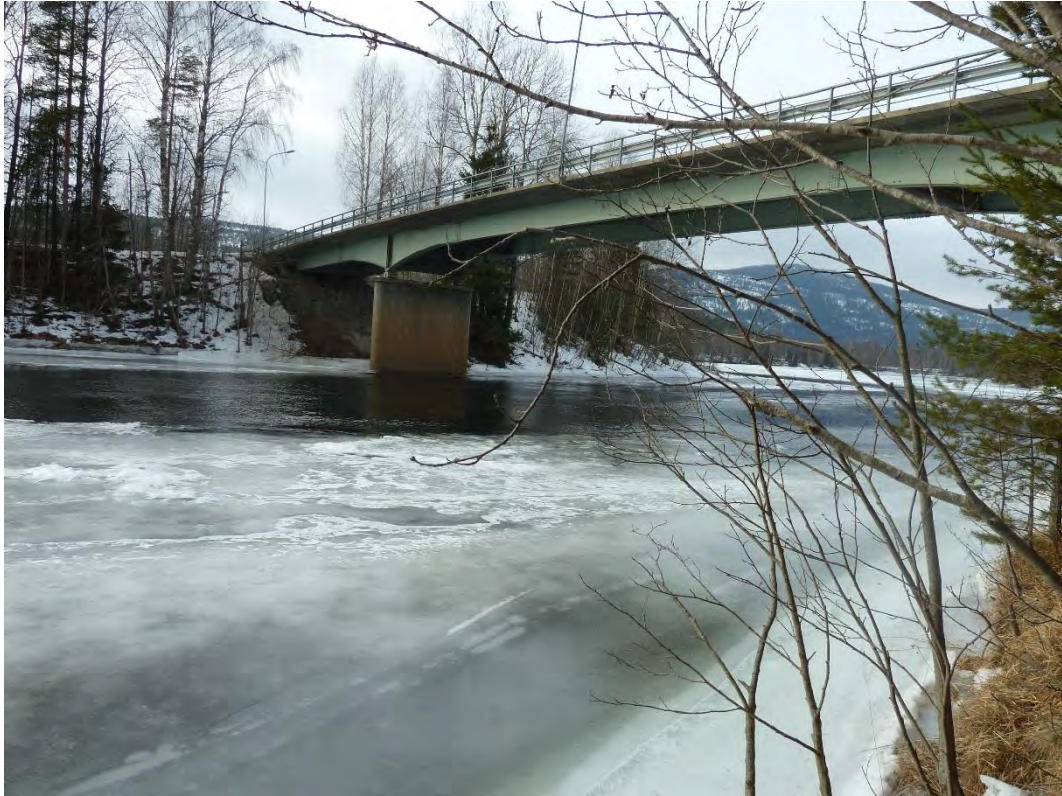
Figur 8 Haugen bro (Befaring 18.02.16)
