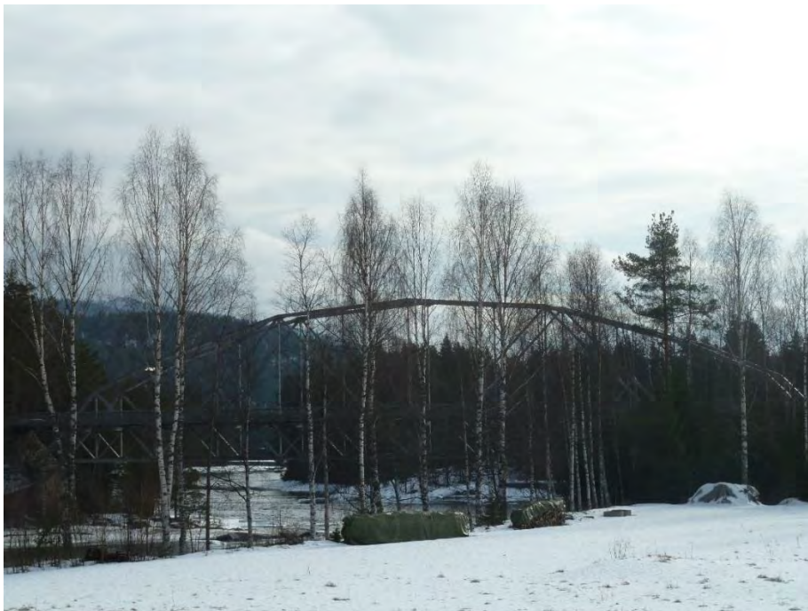
Figur 7 Grettefoss bro (Befaring 18.02.16)
