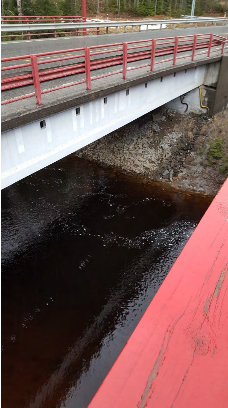
Figur 9 Fløttaker bro (Befaring 18.02.16)
