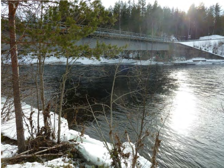
Figur 6 Toskjestyken bro (Befaring 18.02.16)
