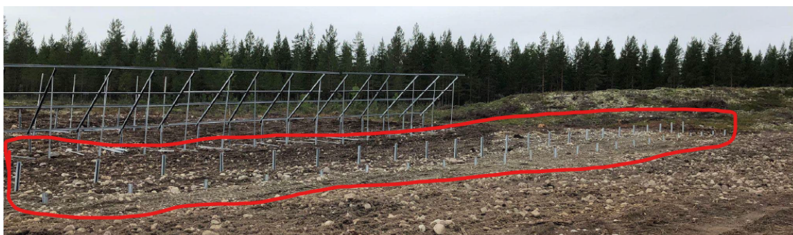
Bilde 1. For å teste ut metoden med graving av grøfter er det gjennomført prøvegraving og peling av ca. 20 stativer. Bildet viser pelene i ferdig komprimert grøft.
