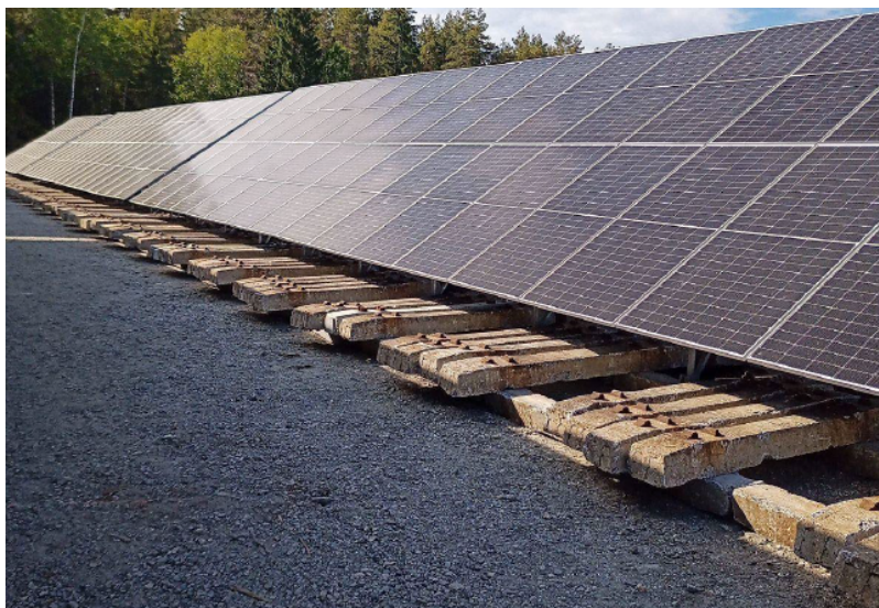
Bilde 2. Linjefundament med betongelementer som ballast.
