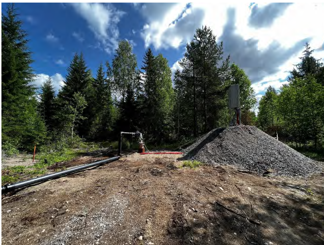
Figur 7: Oversiktsbilde som viser Brønn 7 og elektroskapet som er knyttet til brønnen. Svart rør går fra brønnen og ut i Vesle Vingersjøen og vannet som blir pumpet opp fra brønnen under prøvepumping går denne veien.
