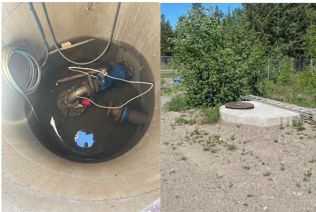
Figur 4: Bildene som viser plassering av brønn og ned i brønnkum for Brønn 2. Bilde er tatt av GIVAS 22.05.2024 og det har i forkant av bildetaking vært flom i området i forbindelse med snøsmelting.
