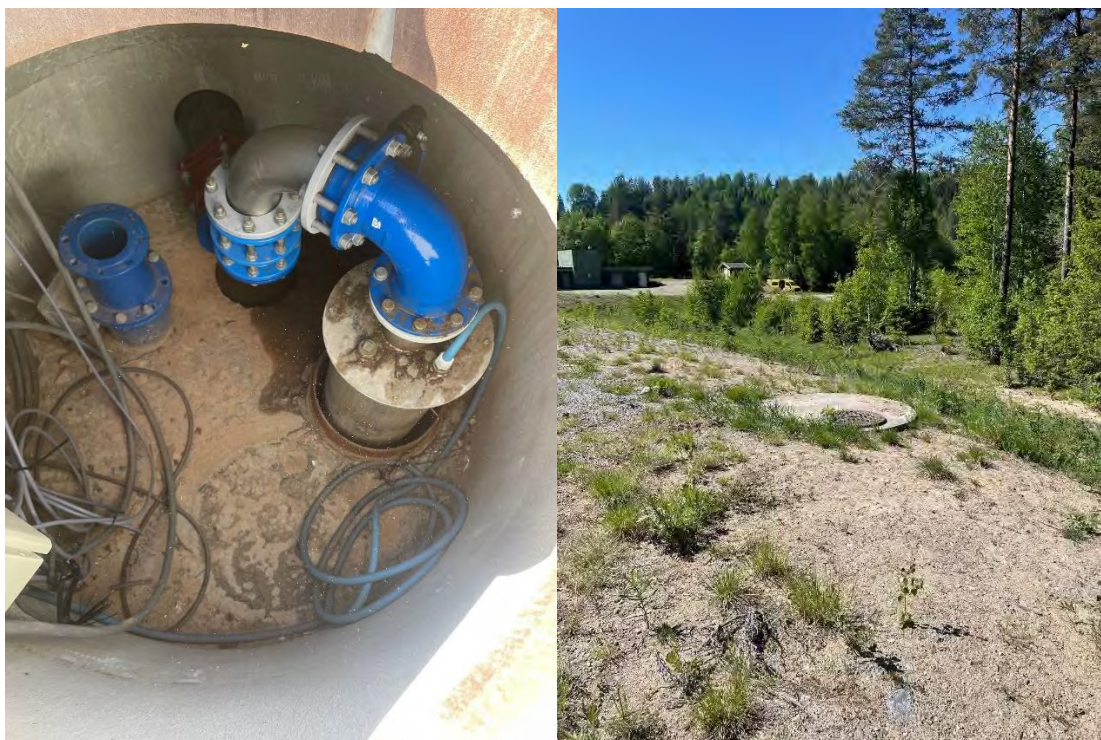
Figur 5: Bildene som viser plassering av brønn og ned i brønnkum for Brønn 5. Bilde er tatt av GIVAS 22.05.2024 og det har i forkant av bildetaking vært flom i området i forbindelse med snøsmelting.
