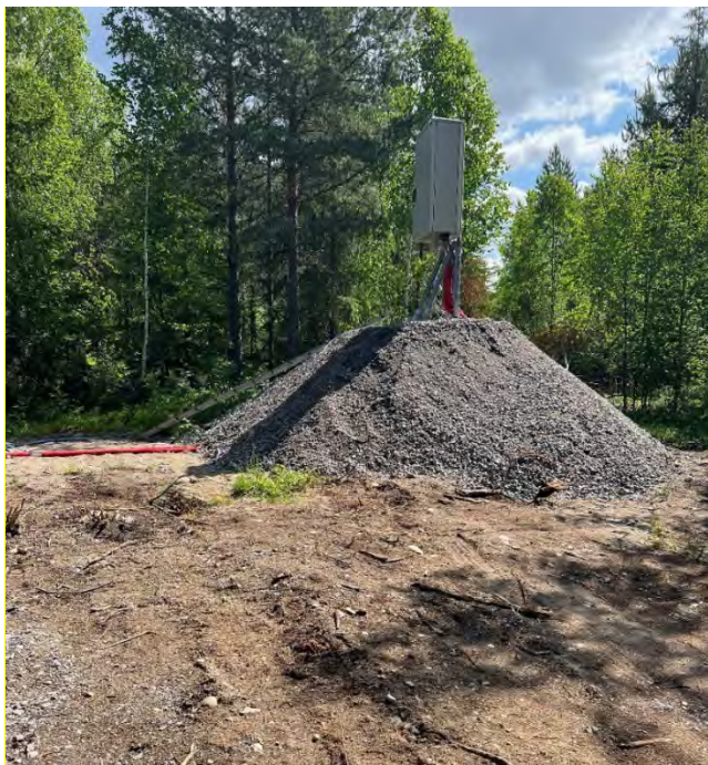
Figur 14: Viser tiltaket som er gjort ved Brønn 7 og Brønn 8 for å sikre at strømskapet til de nye brønnene står sikkert med tanke på flom.
