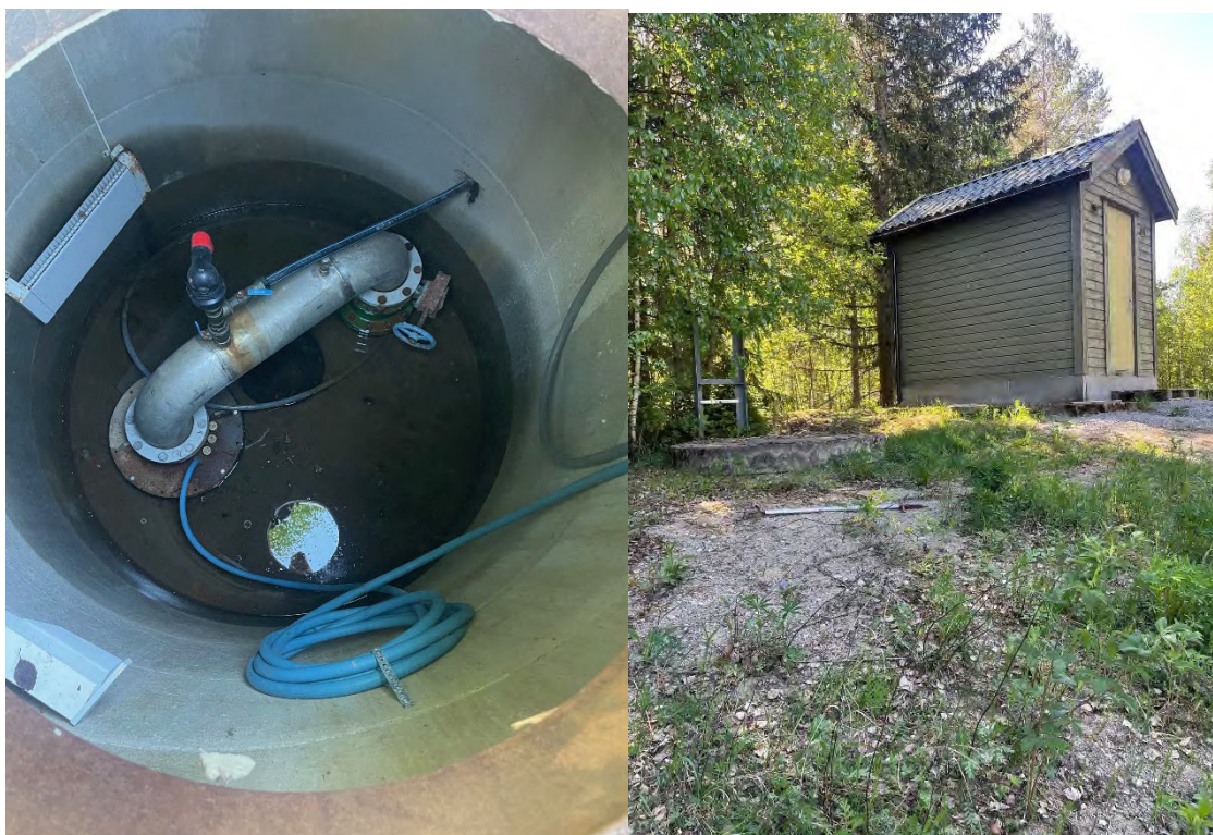
Figur 15: Bildene som viser plassering av brønn og ned i brønnkum for Brønn 1. Bilde er tatt av GIVAS 22.05.2024 og det har i forkant av bildetaking vært flom i området i forbindelse med snøsmelting.
