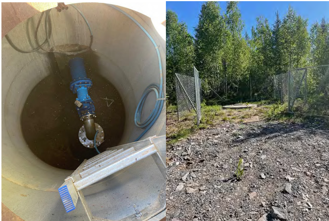
Figur 18: Bildene som viser plassering av brønn og ned i brønnkum for Brønn 6. Bilde er tatt av GIVAS 22.05.2024 og det har i forkant av bildetaking vært flom i området i forbindelse med snøsmelting.
