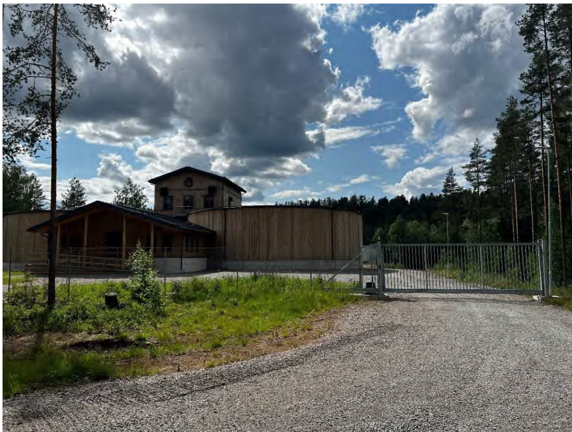
Figur 2: Bilde viser det nye renseanlegget til Granli vannverk som sto ferdig og ble tatt i bruk for fult august 2023.
