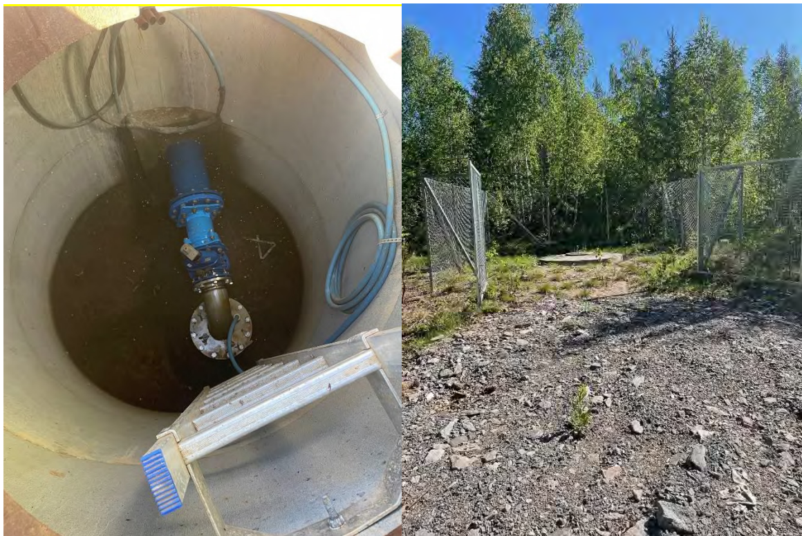
Figur 6: Bildene som viser plassering av brønn og ned i brønnkum for Brønn 6. Bilde er tatt av GIVAS 22.05.2024 og det har i forkant av bildetaking vært flom i området i forbindelse med snøsmelting.
