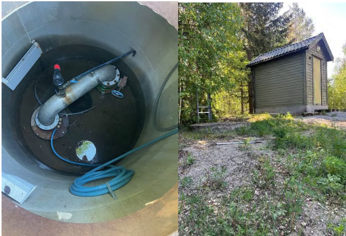
Figur 3: Bildene som viser plassering av brønn og ned i brønnkum for Brønn 1. Bilde er tatt av GIVAS 22.05.2024 og det har i forkant av bildetaking vært flom i området i forbindelse med snøsmelting.
