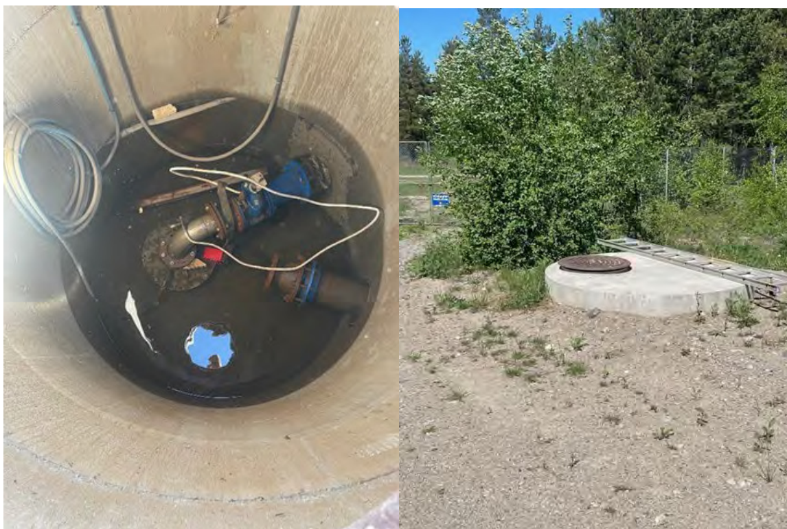
Figur 16: Bildene som viser plassering av brønn og ned i brønnkum for Brønn 2. Bilde er tatt av GIVAS 22.05.2024 og det har i forkant av bildetaking vært flom i området i forbindelse med snøsmelting.
