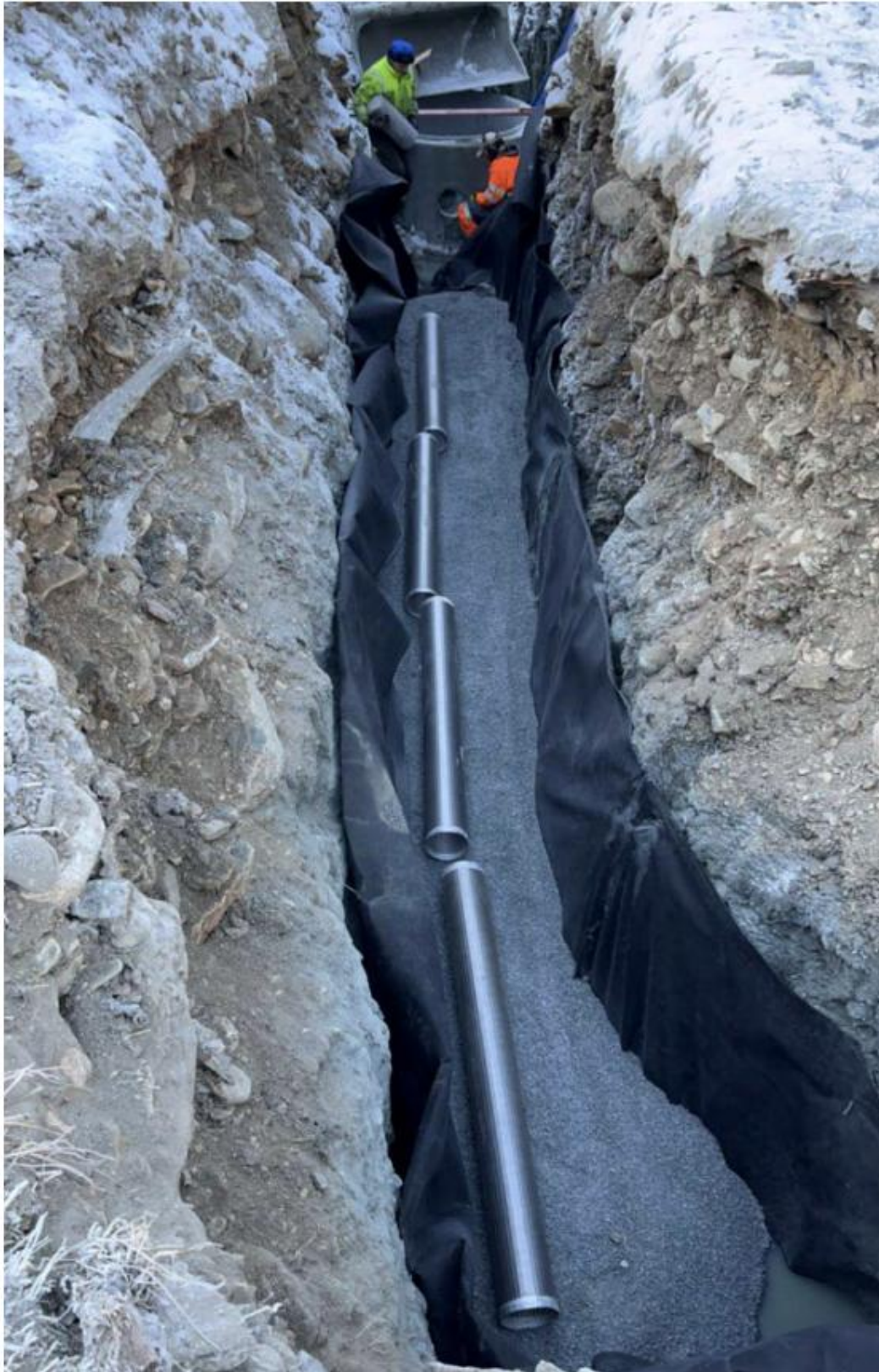
Figur 18 Legging av røyr i grøft. Ut mot stadeigne massar ligg det ein fiberduk. Rundt brønnrøyr ligg det vaska singel.
