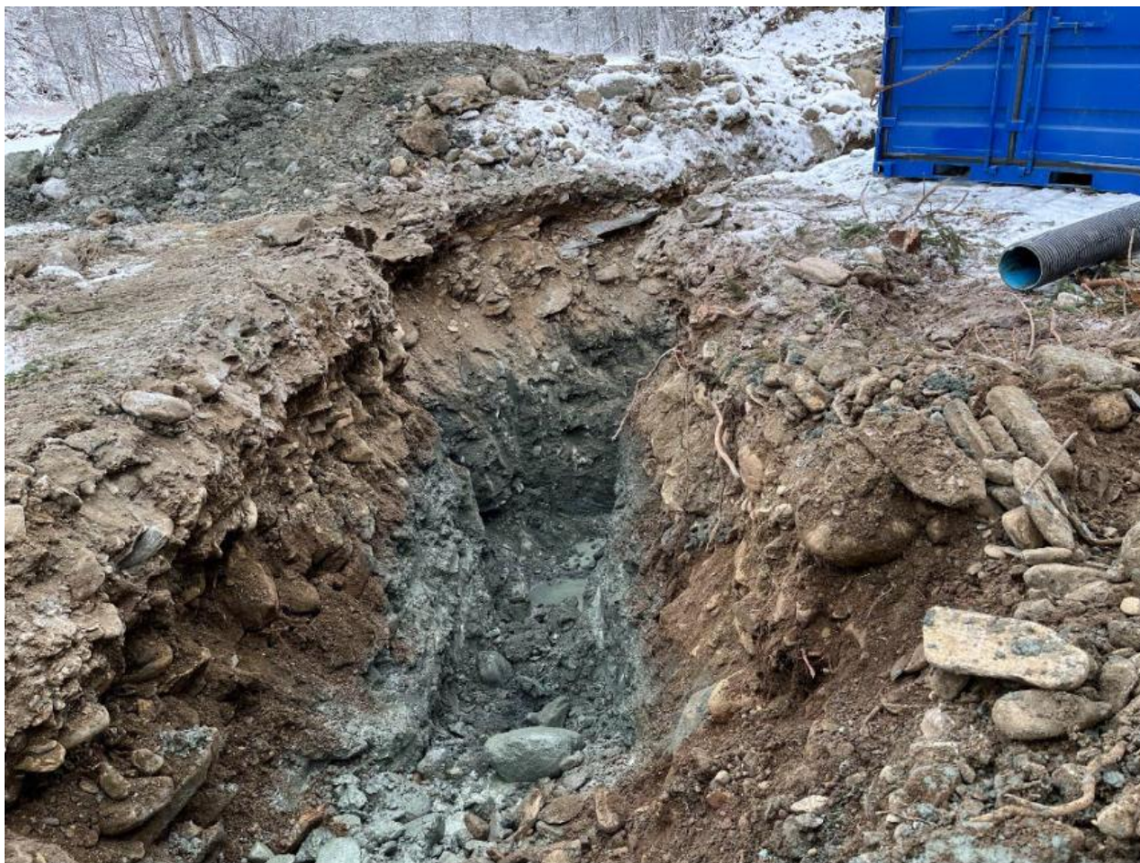
Figur 9 Graving av ei grøft som viser grove oksyderte grovkorna massar over grå morene.
