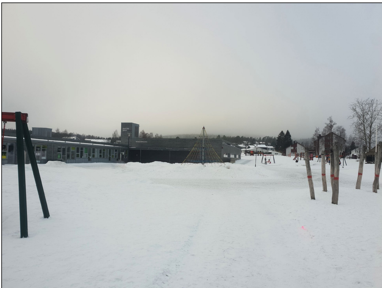
Bilde av eksisterende Skjetten skole, tatt mot sørvest.
