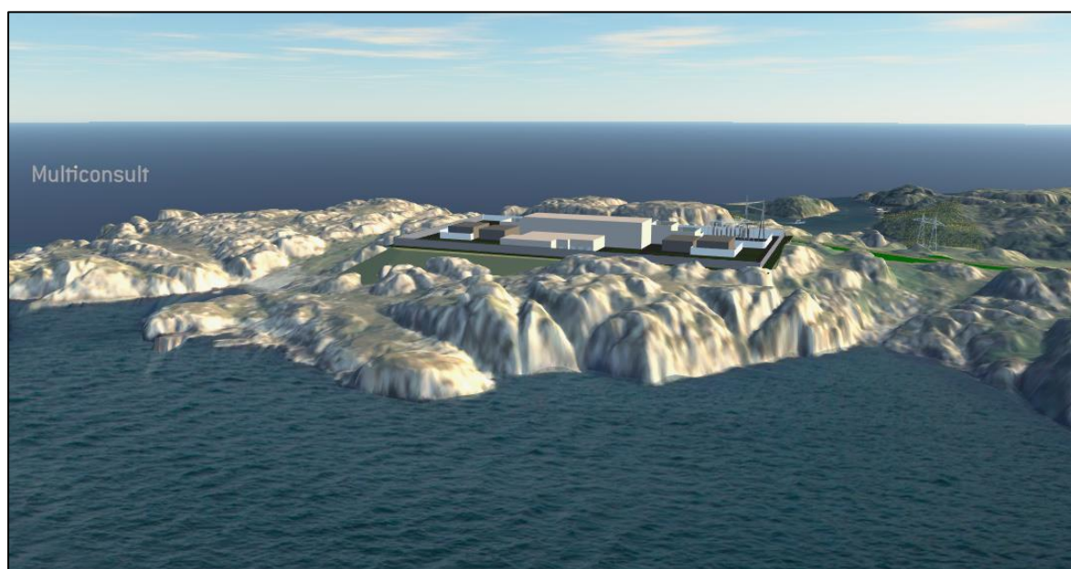
Figur 17. Eksempel på transformatorstasjon i Sjøvika. Denne er tilrettelagt for tilkobling av flere olje-/gassfelt og planlagt vindkraft fra Utsira Nord, og dekker et areal på ca. 50 daa. En tilkobling av kun NOA/Krafla vil kreve omtrent halve arealet.
