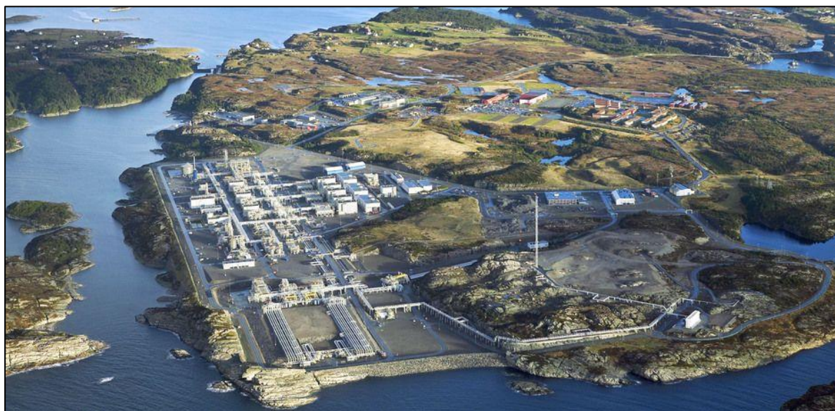
Figur 21. Oversiktsbilde av Kollsnesanlegget. Kilde: Equinor.
