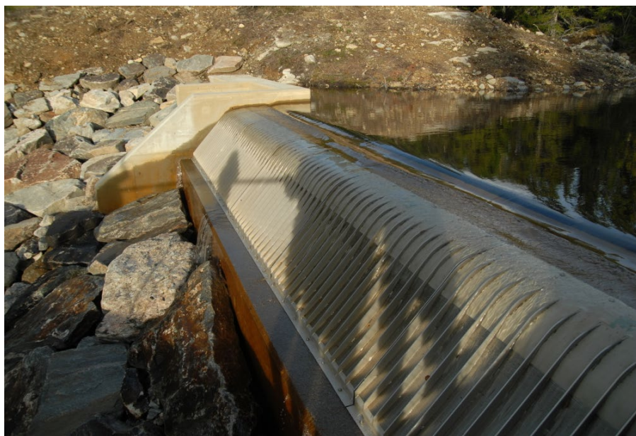
Figur 3: Eksempel på coandainntak, Nybuelve kraftverk, rett etter endt anleggsperiode
