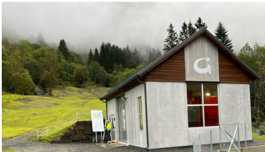
Figur 2: Eksempel på kraftstasjon med nedgravd rørgate og påhugg, Tverrelvi kraftverk, tre måneder etter avsluttet anleggsarbeid
