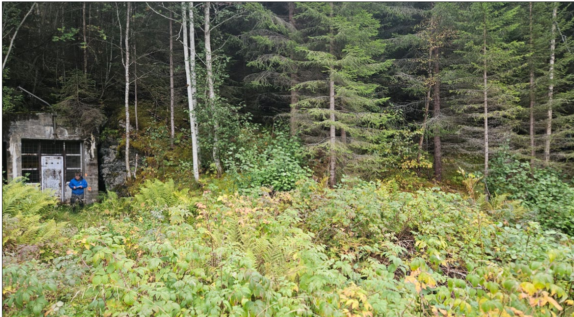
Figur 16. Eksisterende portalbygg til dagens svingetunnel. Nytt påhugg og portalbygg plasseres i fjellskjæringen bak trærne til høyre i bildet. Foto mor øst.
