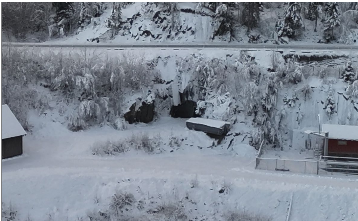
Figur 12. Dagens situasjon i inntaksområdet. Nærbilde av område for forskjæring, påhugg og portal til ny adkomsttunnel. Foto mot vest.
