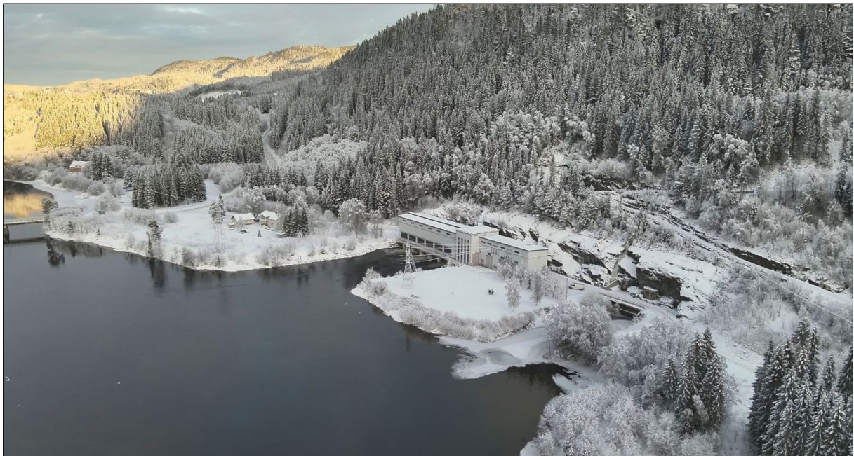
Figur 5. Dagens situasjon i kraftstasjonsområdet. Fjellskjæringen til høyre for kraftstasjonsbygningen forlenges. Eksisterende vei mot portal for svingesjakt strekker seg oppover i lia bak kraftstasjonen. Foto fra vest/sørvest.
