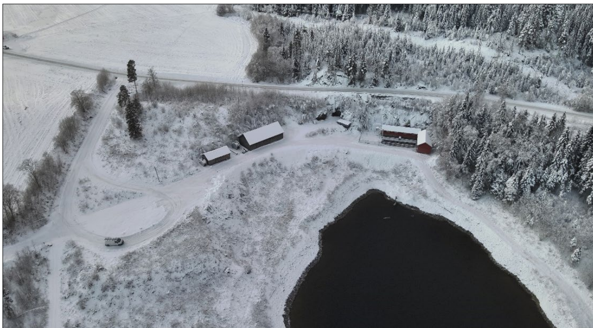
Figur 10. Dagens situasjon i inntaksområdet. Området har adkomst med avkjøring fra fv. 6704. Portalbygget plasseres i fjellskjæringen under fv. 6704, omtrent midt i bildet. Eksisterende bygninger skal rives. Foto mot vest.
