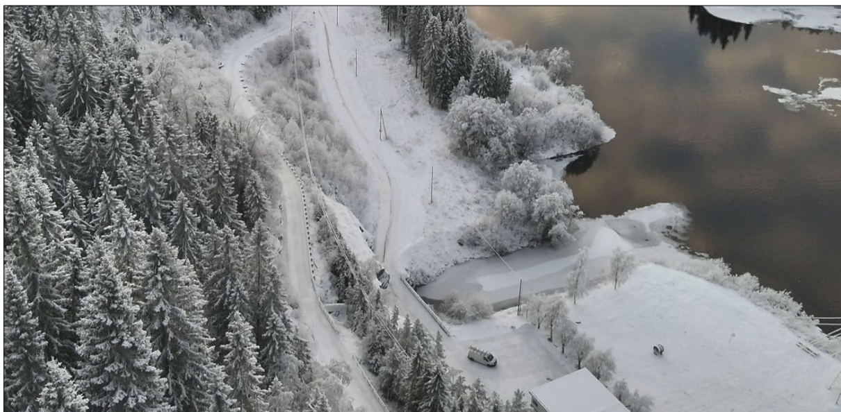
Figur 6. Dagens situasjon i kraftstasjonsområdet. Frosset forbitappingskanal. Eksisterende vei mot portal for svingesjakt til venstre i bildet. Foto mot sør.
