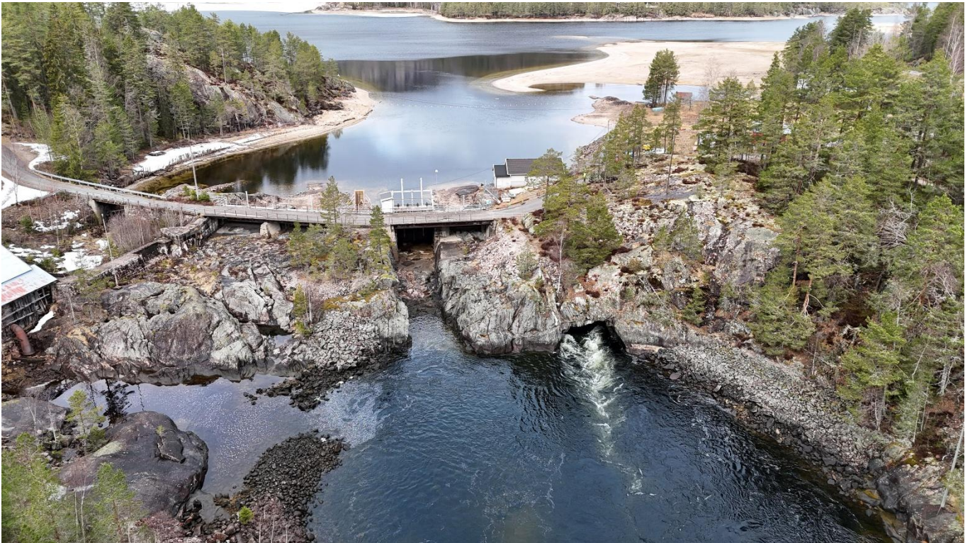
Figur 2: Dronefoto (Njord Vannkraft) over tiltaksområdet
