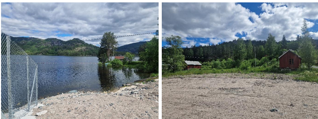
Figur 5 Området nord for vei, anleggsområde og midlertidig deponi for masser.
