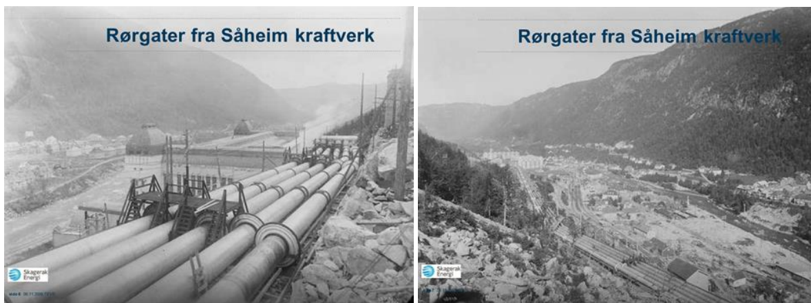
Figur 17 Rørgater fra Såheim kraftverk
