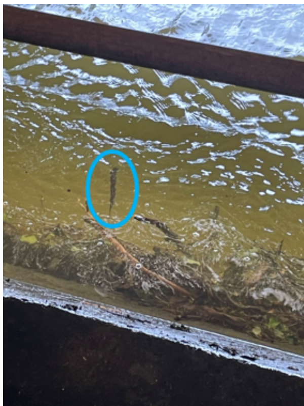
Figur 6: Til venstre: En ørret svømmer foran finvaregrinden foran turbinen (blå sirkel). Lysåpningen i varegrinden er 30 mm. Til høyre for inntaket til turbinen er det en luke som var inntaket til det gamle kraftverket. Søker ønsker å åpne denne når det observeres fisk foran varegrinda og slippe vann, og fisk, forbi og ut nedstrøms kraftverket. Bildet til høyre viser Follebu Bruk og vannstrømmen på berget er der vannet og fisk kommer ut nedstrøms bruket når luken åpnes. (Bildene tatt av NVE under befaringen 17. juni 2024).
