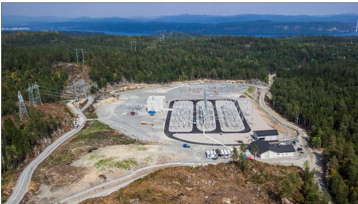
Figur 5-30: Statnetts Bamle transformatorstasjon under bygging. Bildet er tatt retning øst med Frierfjorden i bakgrunnen. Ny Herum transformatorstasjon vil ligge nord for eksisterende stasjon (til venstre i bildet). Foto fra konsesjonssøknad Herum transformatorstasjon (132 kV Hellestveit – Herum).
