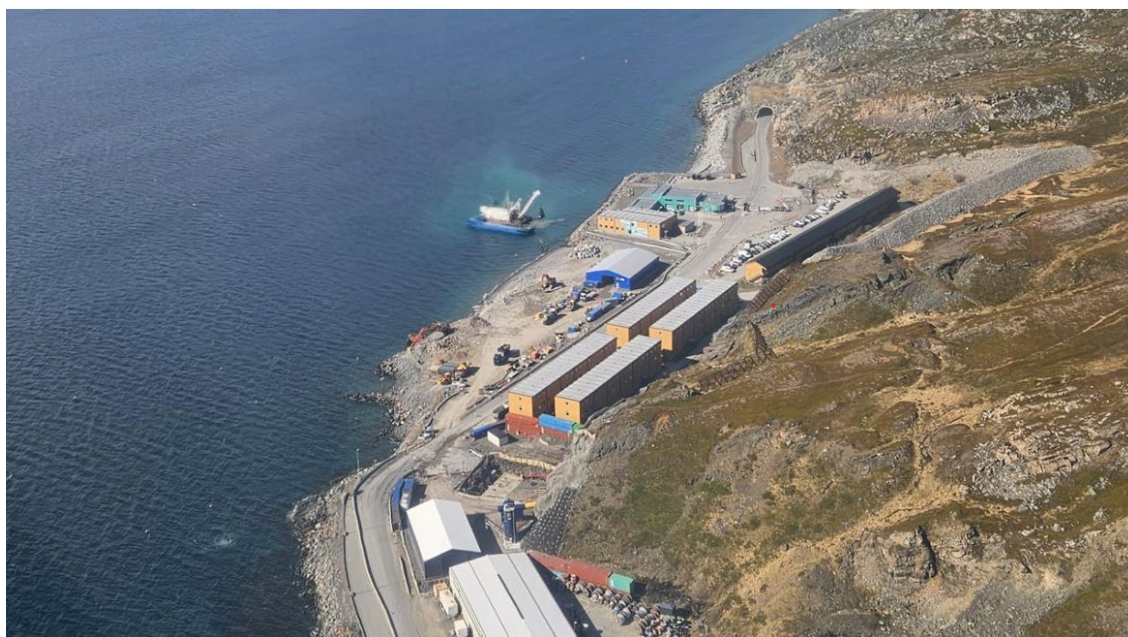
Figur 3-2 Flyfoto av pågående utfylling, 12.05.2026 (Kilde-Multiconsult)
