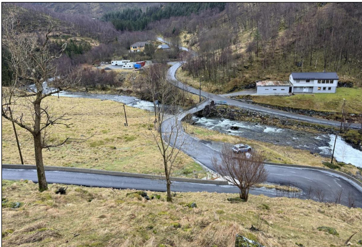
Figur 3: Oversiktsbilde av det kartlagte området med eksisterende bro, sett mot sør.
