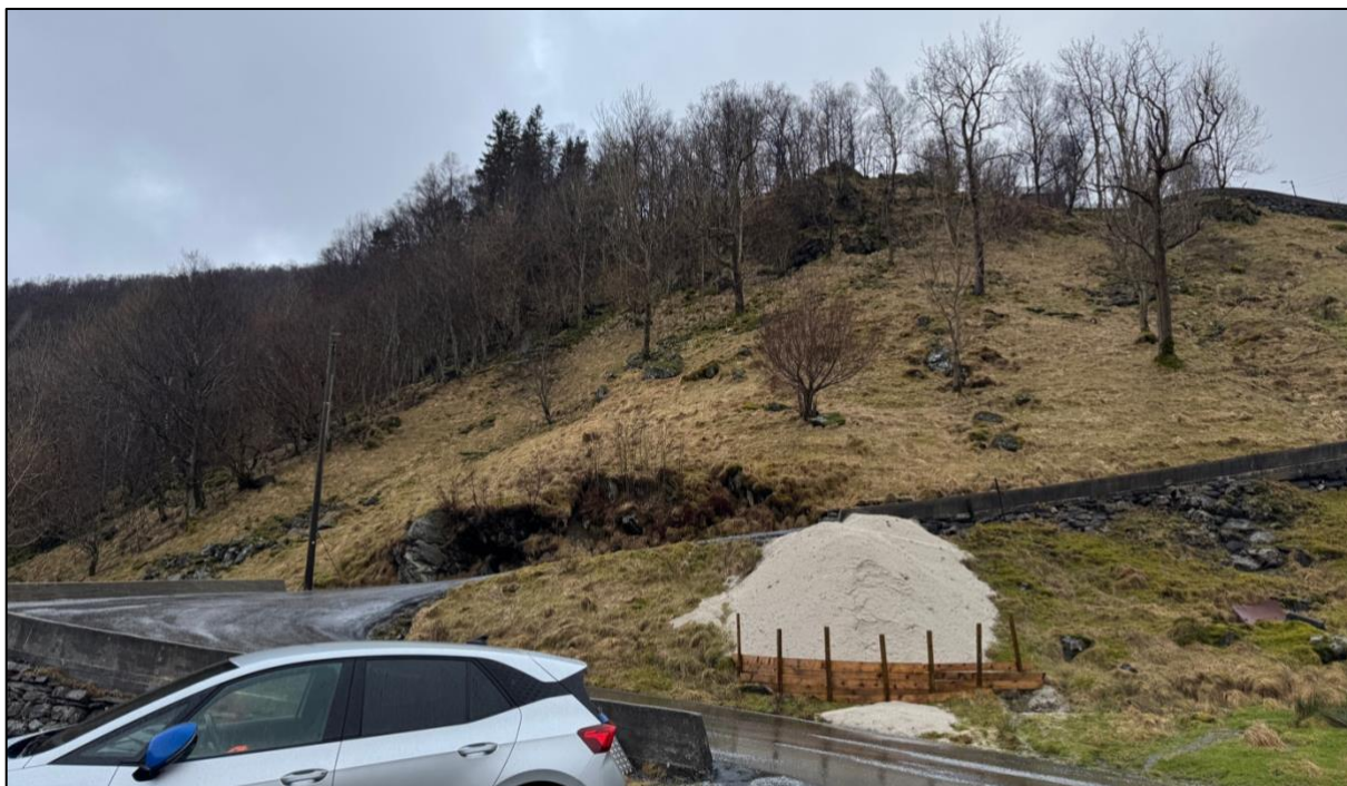
Figur 4: Nord og nordvest for planlagt bru er det en lokal, bratt skråning med løsmasser og en liten bergskrent øverst. Bildet er tatt mot nord-nordvest.
