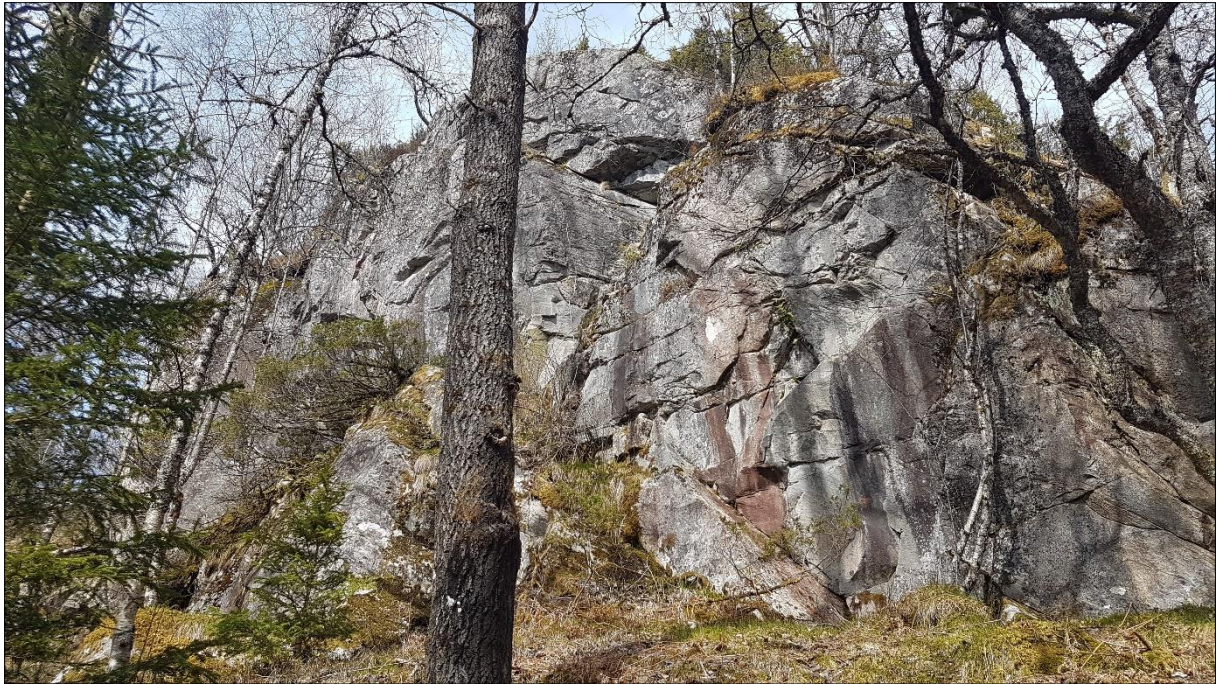
Figur 8: Fjellhammar opp mot 10 m høg i sørvestlege del av kartleggingsområdet. Overflata er generelt lite oppsprokke, men med enkelte ustabile område. Det er lite steinsprangmateriale nedanfor hammaren.
