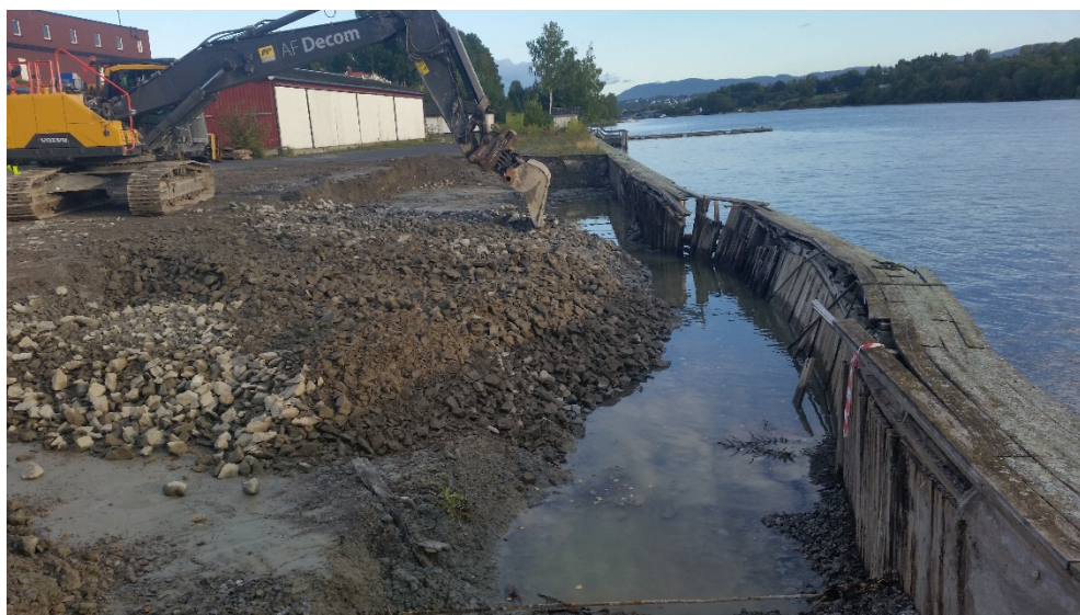
Figur 4: Midlertidig sikring av rasområdet
