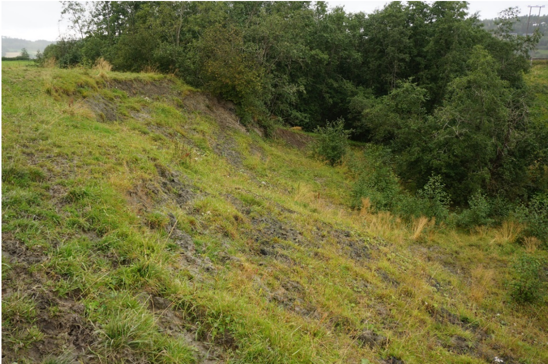
Figur 4 Utglidningen på oversiden av banen som er anslagsvis 10 år gammel.
