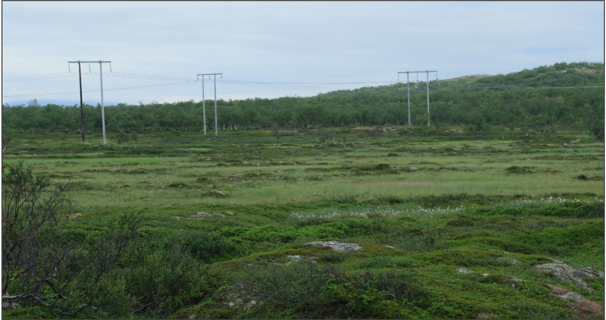
Figur 4-2. Eksisterende 132 + 66 kV ledninger. Her står mastene ikke side om side, slik at man får kabler i ulike høydenivåer.
