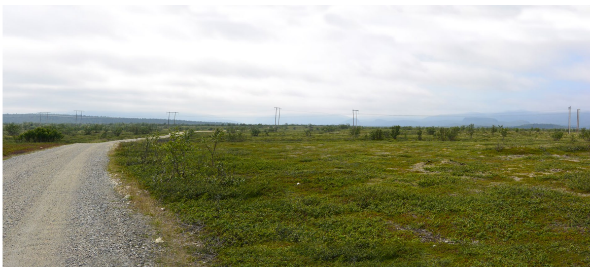
Figur 27: Foto som viser dagens situasjon med 132 kV ledning og 66 kV ledning. Foto er tatt langs vegen inn til nasjonalparken.
