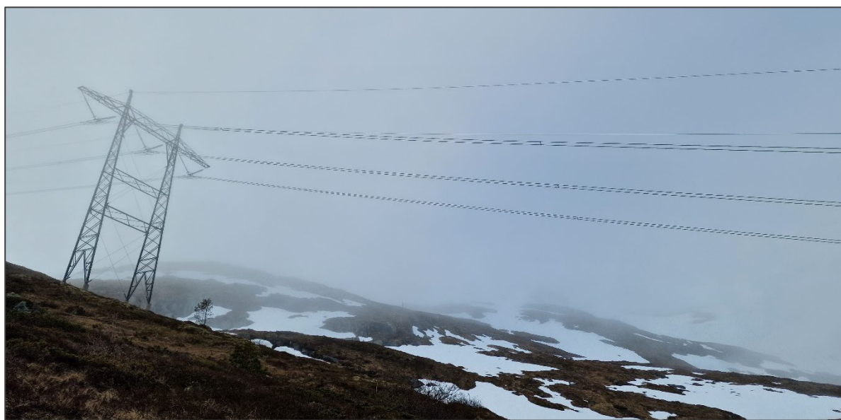
Figur 1-1. De tynne topplinene representerer en større kollisjonsrisiko enn de mer synlige faselederne. Dette eksemplet er hentet fra 420 kV Fardal – Ørskog (som er en duplex-ledning).
