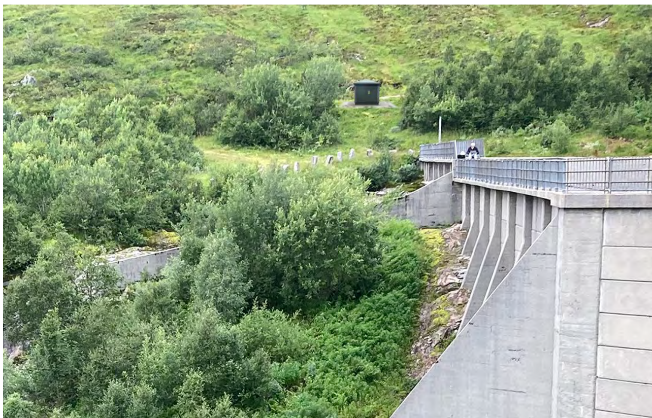
Figur 3-17. Nettstasjon Fossvatn, nærbilde under.
