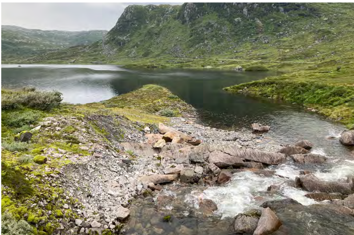
Figur 3-11. Tipp på venstre side av utløpet skal fjernes og massene skal gjenbrukes i anleggsveien. Tippen eroderer, og sprengstein er synlig i elveløpet.
