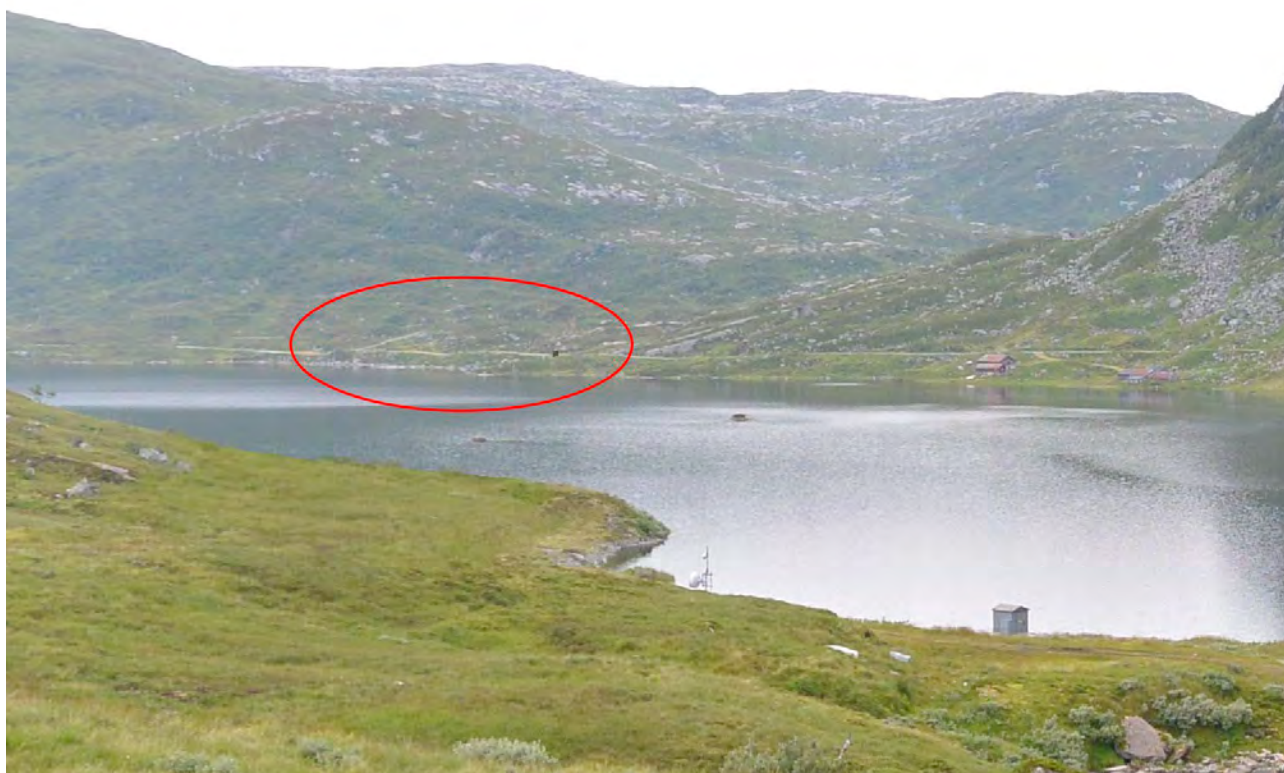
Figur 3-19. Nettstasjon Stordalen vist med rød sirkel, sett fra dam Monsdalsvatn. I forgrunn er det et tilbakeført deponi vest for dagens lukehus.
