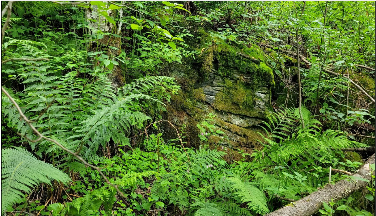
Figur 6: Bildet viser fjell i dagen av gneis som er kraftig oppsprukket. Fjellskrenten er ca. 2 m høy og nedenfor og tett på skråningsfot er det enkelte steinsprangblokker. Blokkene er ikke ferske steinsprang.
