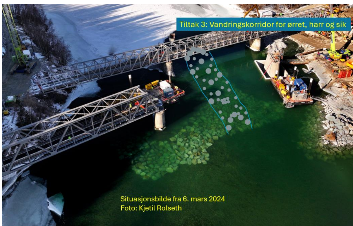
Figur 2-2. Skisse over det planlagte tiltaket under både jernbanebrua og vegbrua med lokalisering av steinutlegging. Utlekking av store steinblokk vil skape bedre hydrauliske forhold for de svømmesterke fiskeartene. Foto: Kjetil Rolseth.
