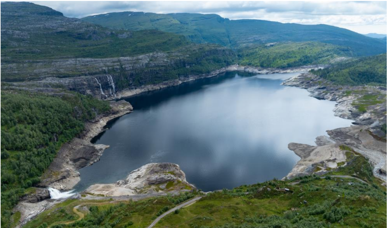
Figur 4. Bilde av reguleringsmagasinet Kvitingsvatnet tatt fra nord mot sydvest. Dagens kraftverksutløp er til venstre i bildet (Bilde: Sweco).
