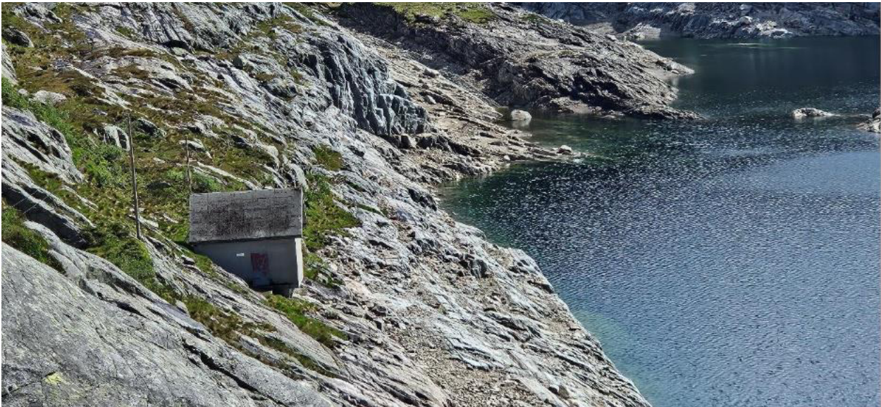
Figur 16: Eksisterende lukehus ved Svartavatnet
