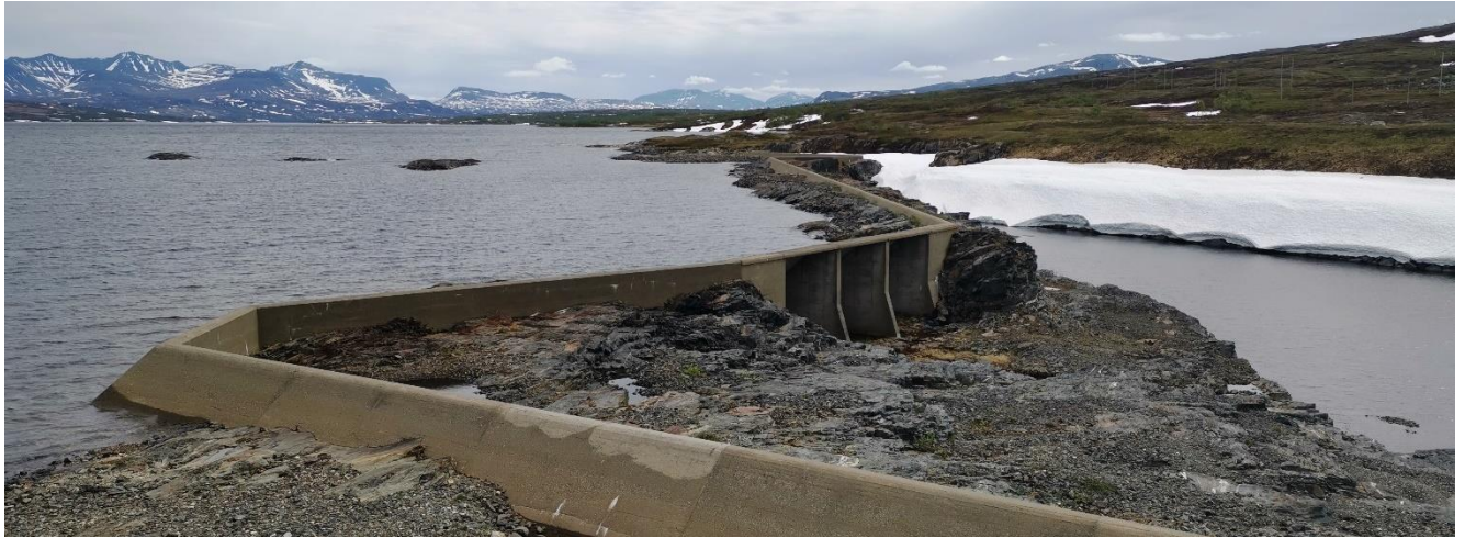
Overløpsdam sett østover fra fyllingsdammens søndre vederlag
