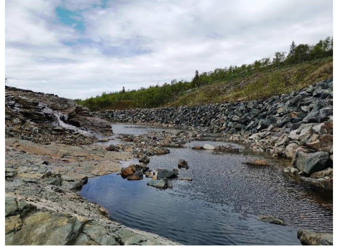
Erosjonssikring i utløp av omløpstunnel
