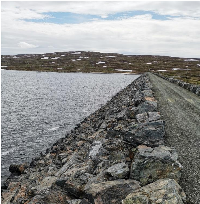
Oppstrøms damskråning sett mot sør
