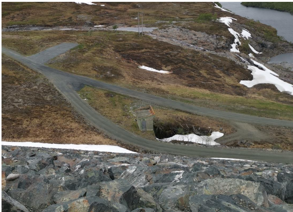
Figur 2-15: Portalbygg og forskjæring for adkomsttunnel sett fra damkrone
