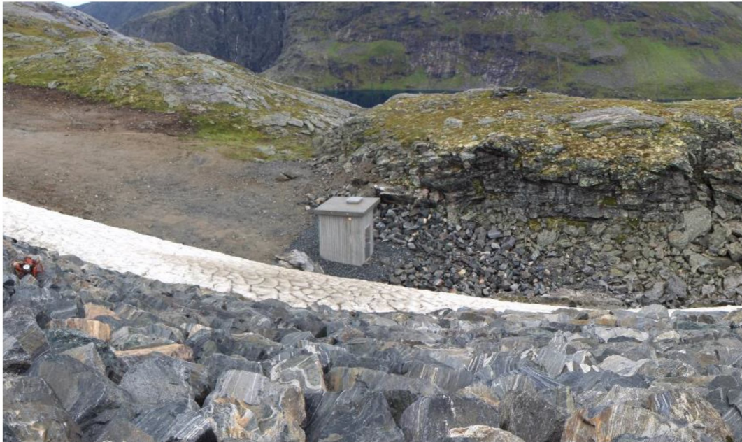
Figur 2-12: Eksempel på utførelse av lekkasjemålehus. Bildet er tatt ved et annet Statkraftanlegg.
