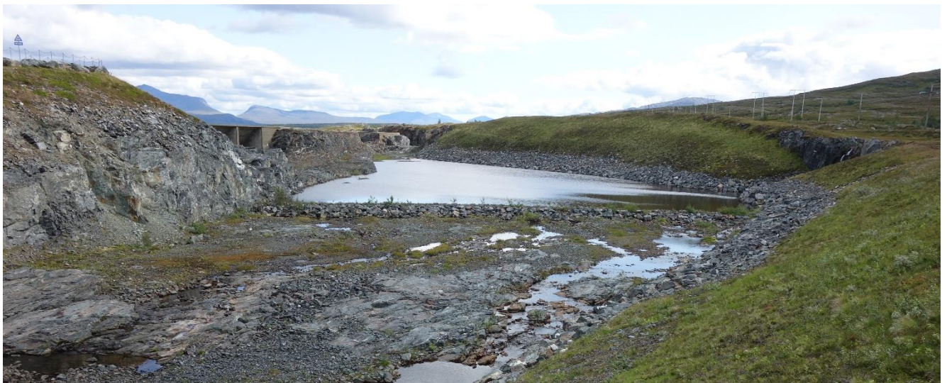
Flomkanalen sett motstrøms
