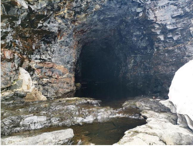
Utløp av eksisterende omløpstunnel
