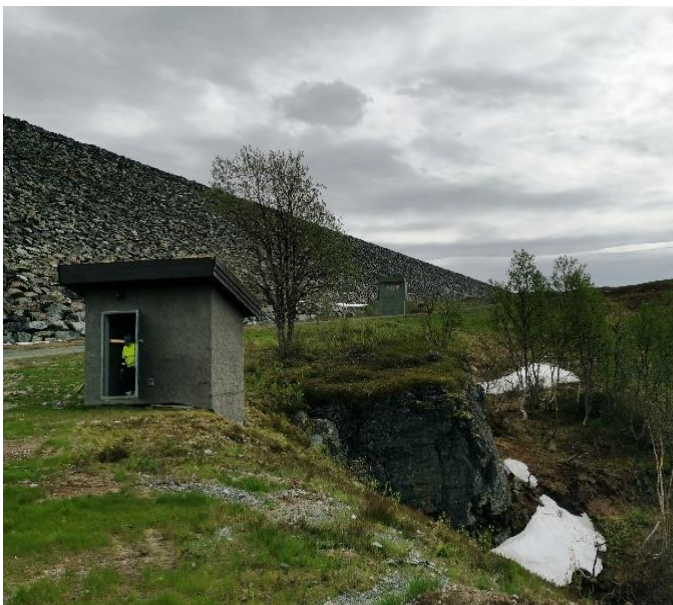
Adkomsthus til lekkasjemålepunkt 1.
