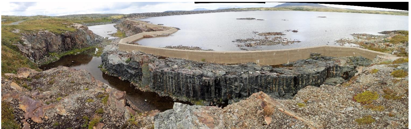
Oppstrøms ende av flomkanalen sett medstrøms
