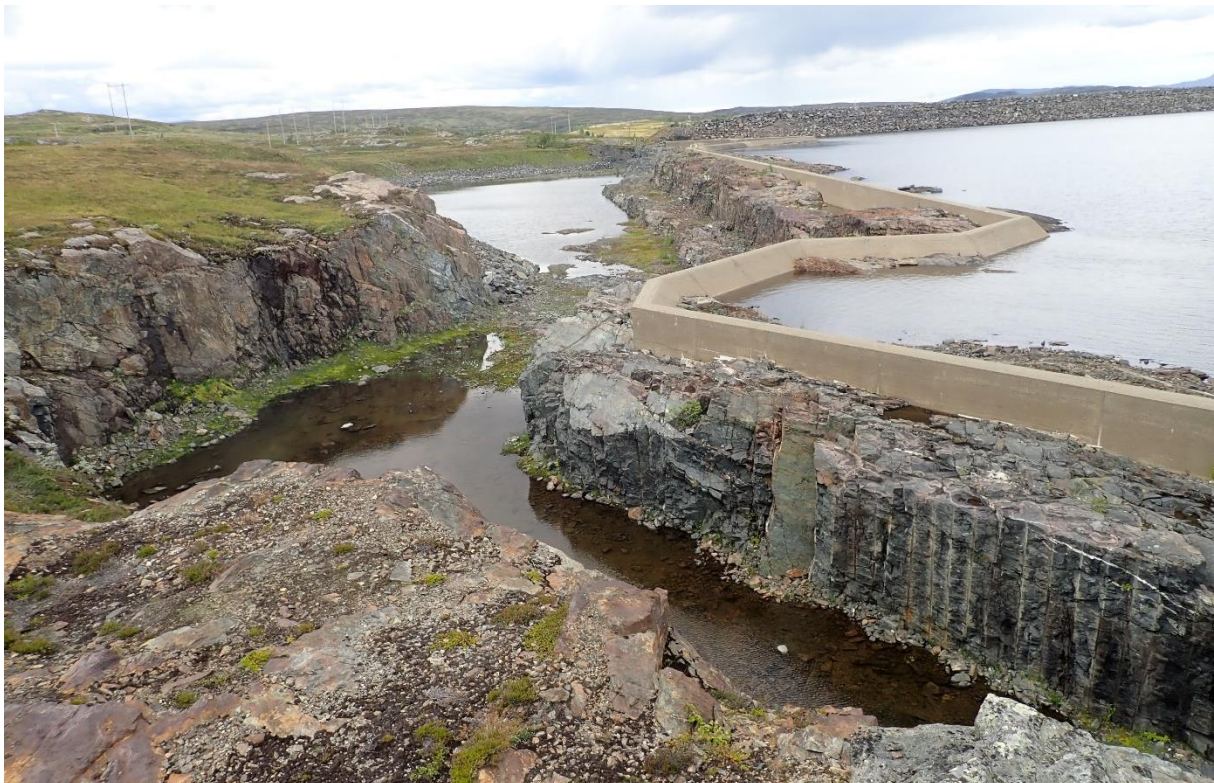
Figur 2-21: Overløp og flomkanal sett fra øst. Planlagt utvidelse medfører uttak av fjellparti til venstre i bildet
