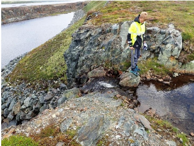
Innløp bekk i flomkanal
