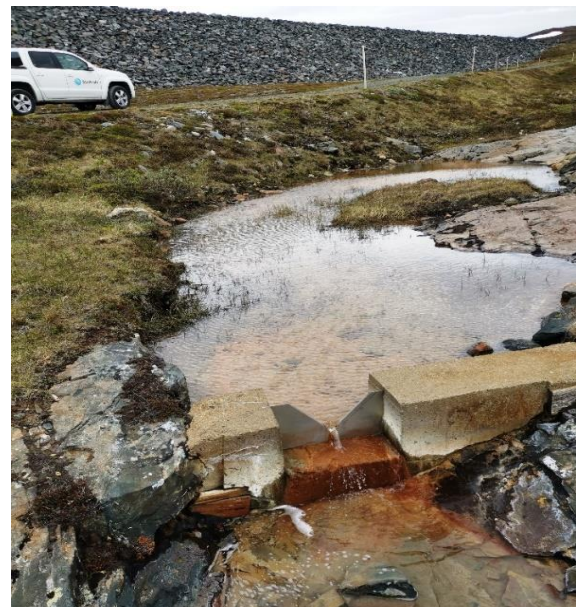
Lekkasjemålepunkt 2 sett motstrøms. Dette skal erstattes med ny målekum ved damfot.
