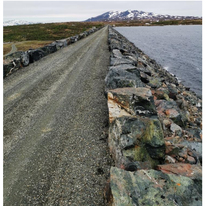
Damkrone og deler av oppstrøms skråning sett mot nord
