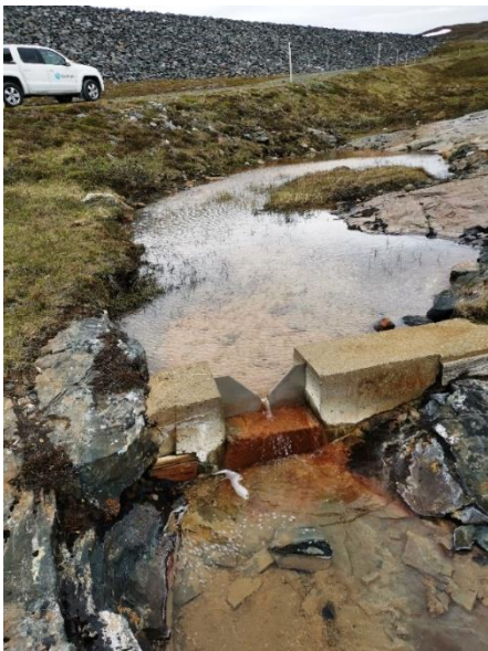
Figur 2-10: Eksisterende lekkasjemålepunkt 2 sett motstrøms
