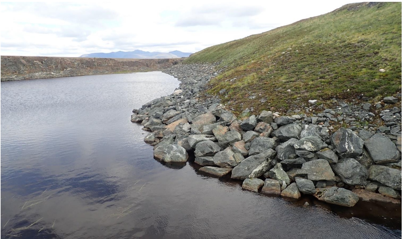
Erosjonssikring i nedre del av gjenfylling i flomkanalsteinbrudd
