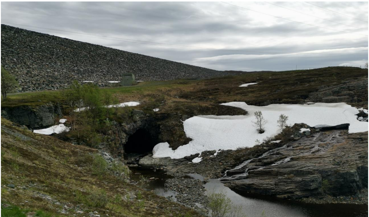
Området ved utløp omløpstunnel
