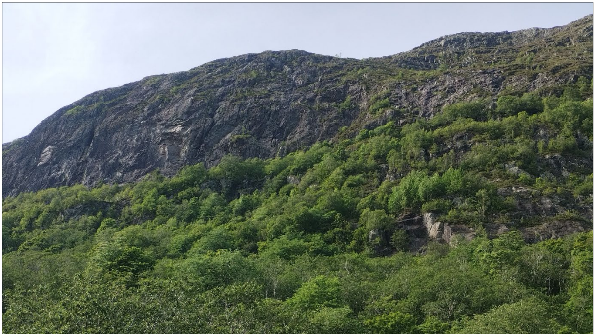
Figur 10: Bilde viser deler av fjellsiden i påvirkningsområdet og i dette området er det vurdert at det kan løsne steinskred. Infopunkt 8.
