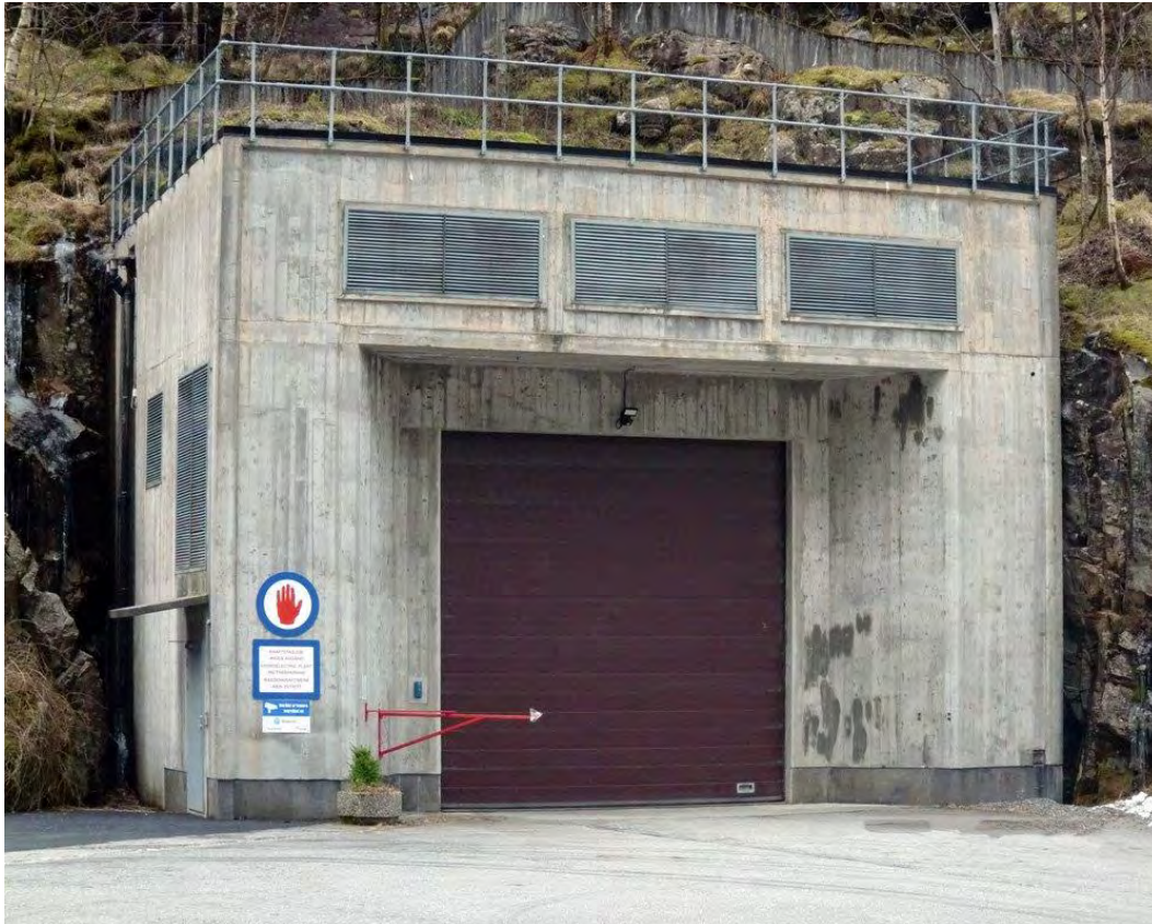
Figur 6. Portalbygget med innkjøring til adkomsttunnelen for Mauranger kraftverk. Bilde: Geir J. Knudsen.
