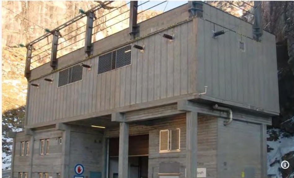
Figur 7. Portalbygget til Jukla pumpekraftverk. Bilde: Geir J. Knudsen.
