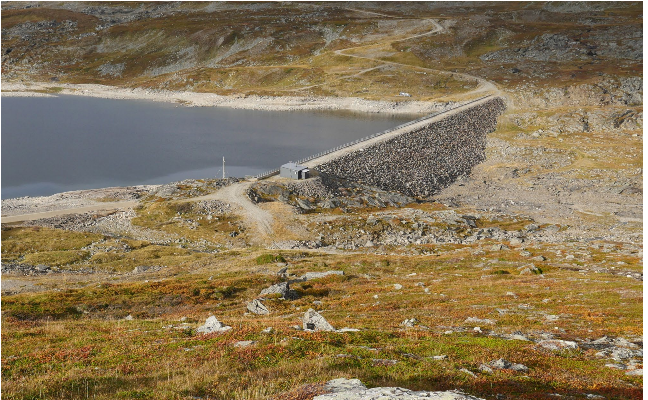
Figur 3-10. Dam Šuoikkátjávri før rehabilitering.
