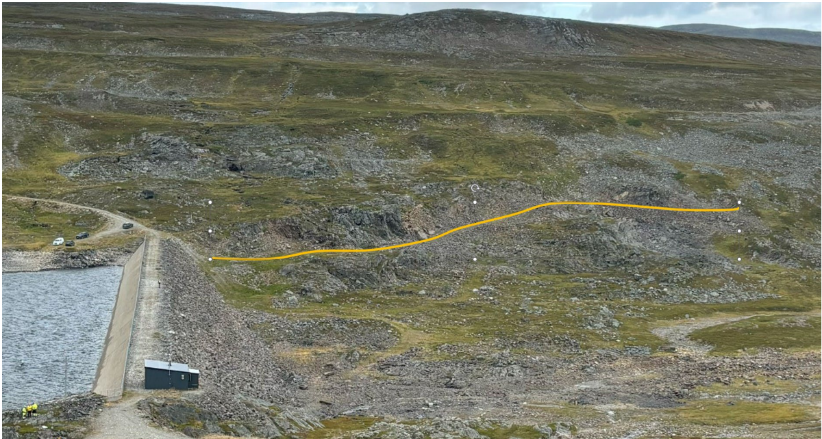
Figur 3-19. Oversikt over vestsiden av dammen. Det er tatt ut masser langs anleggsveien som er vist med oransje strek.
