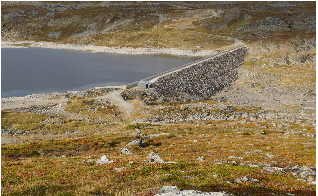
Figur 3-11. Dam Šuoikkátjávri etter rehabilitering. Dammens høyde er hevet, men det blir ikke større på nedstrøms side. En motfylling i magasinets oppstrømside vil bli i noen grad synlig, avhengig om standpunkt og vannstand.
