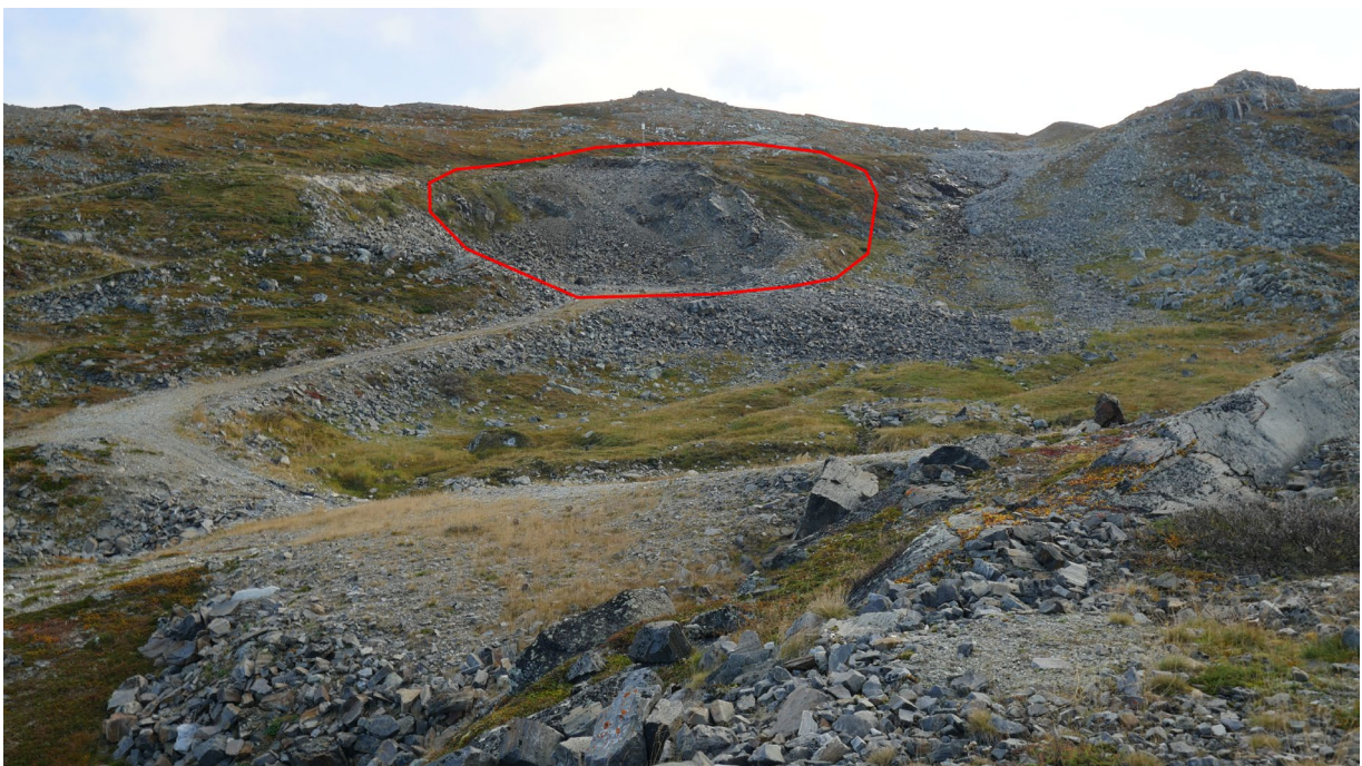
Figur 3-23. Eksisterende masseuttak øst for dammen sett fra overløpet mot øst. Omfanget av forventet inngrep i forbindelse med planlagt uttak er vist med rød strekning. Det er viktig at avgrensingene følger søkkene i terrenget slik at de synlige skjæringshøydene blir minst mulig.
