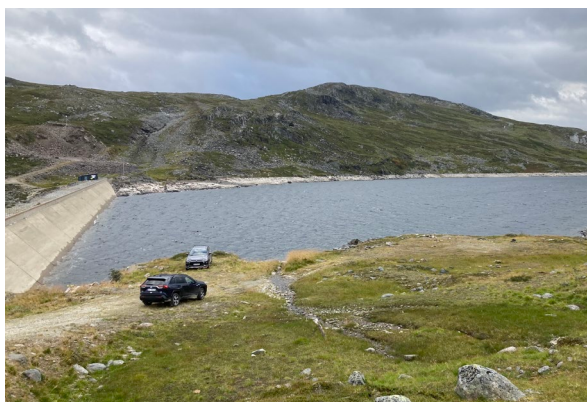
Figur 3-16. R/L Hoved. Tilbakeføring av parkering skal arrondere terrenget slik at bekken ledes rundt parkeringsområdet. Avkjørsel fra Suoikkatveien skal fjerne slik at areal blir ikke brukt til parkering i fremtiden.
