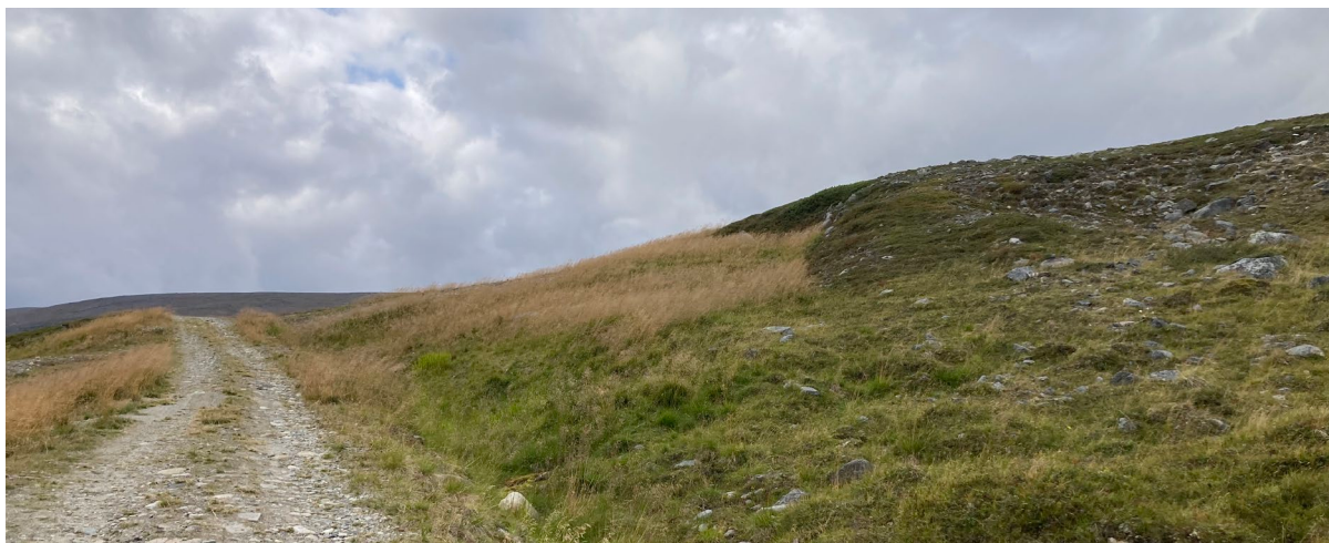
Figur 3-21. Opprannede løsemasser mellom R/L Vest og R/L Hoved. Det mørke arealet til høyre er et lag som er ca. 1 meter høyt av stedlige masser.
