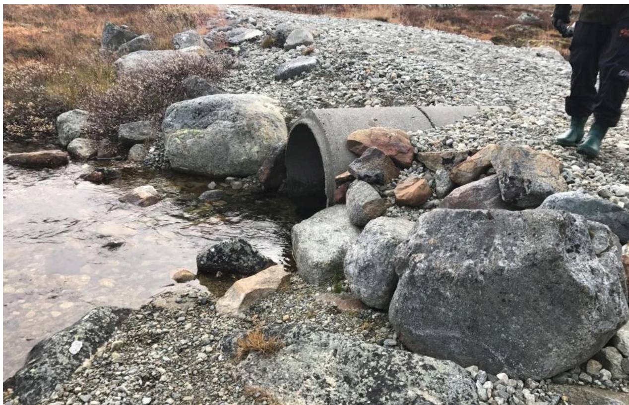
Figur 4: Grunneiere mener at stikkrenne må byttes og nytt dekke må legges over veien
