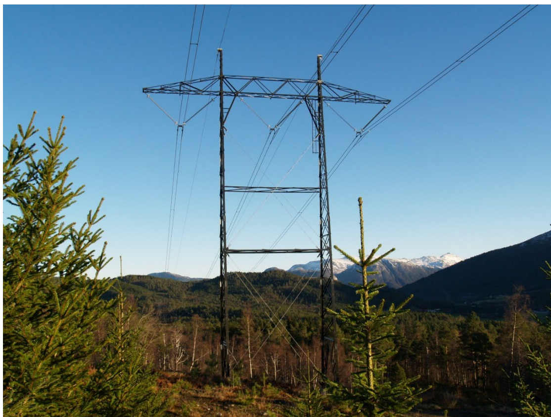
Figur 7 Nærbilde av standardmast bæremast med dupleks ledninger. Foto: Statnett.
