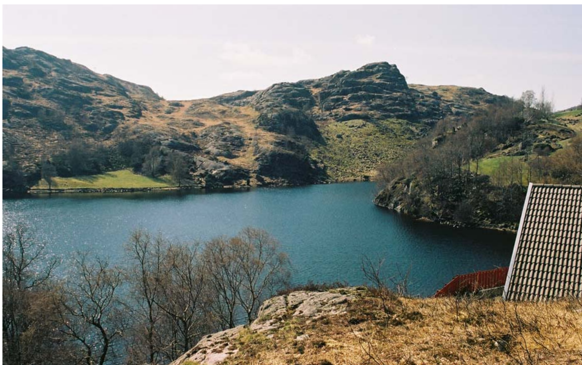
Botnavatnet, inntaksmagasin for Frøytlog småkraftverk
